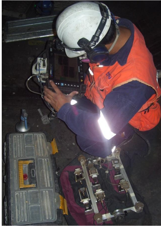
Fotografía N°5.1. Inspección de Ultrasonido, con uso de tecnología TOFD.
