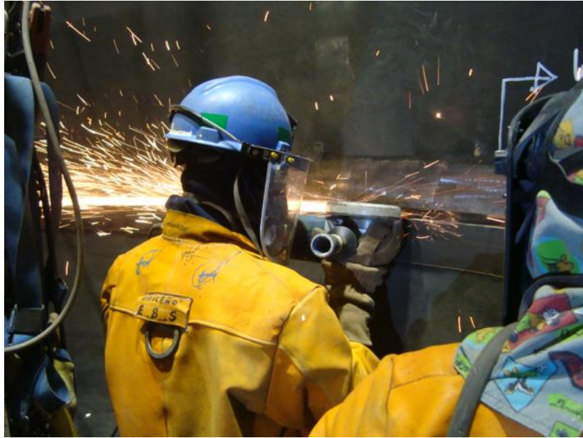
Fotografía N° 4.10. Limpieza de junta por esmeril eléctrico
