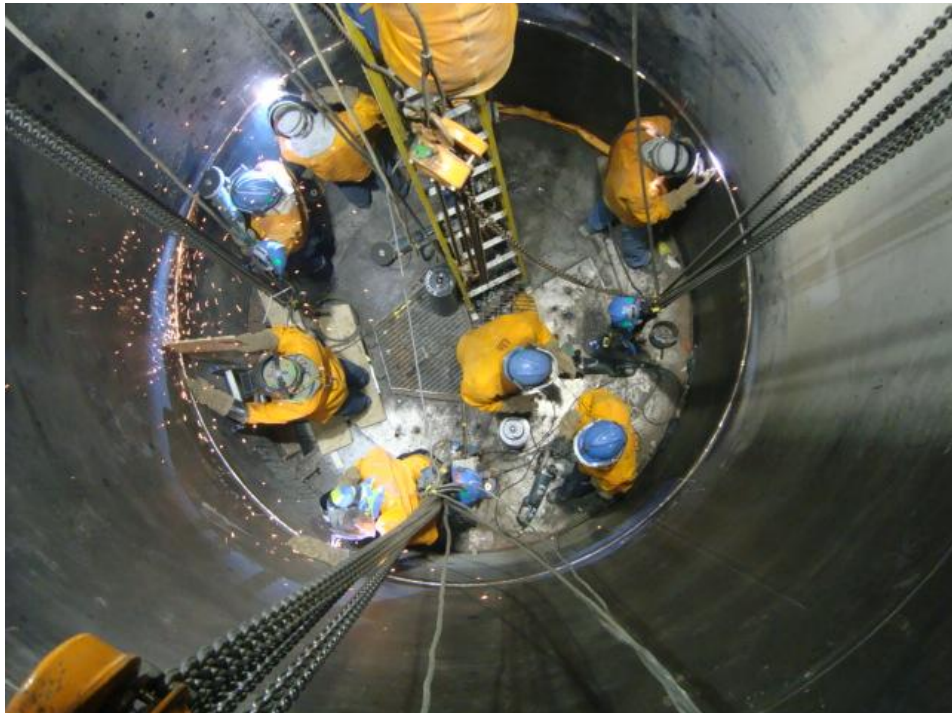
Fotografía N° 4.12. Plataforma de soldeo para montaje de tubería.
