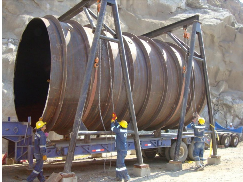
Fotografía N° 4.11. Maniobra de traslado de tubería de Camabaja a estructura de pórticos.
