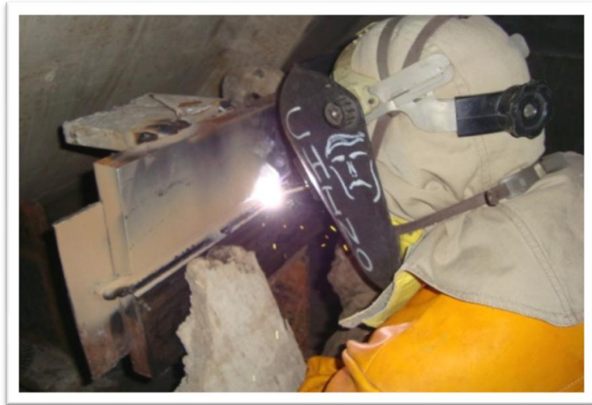
Fotografía N°3.1. Preparación de Cupón de Pruebas
