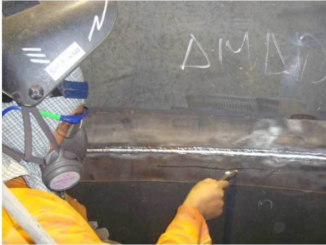
Fotografía N° 4.5. Control de Temperatura por lápices de Temperatura.
