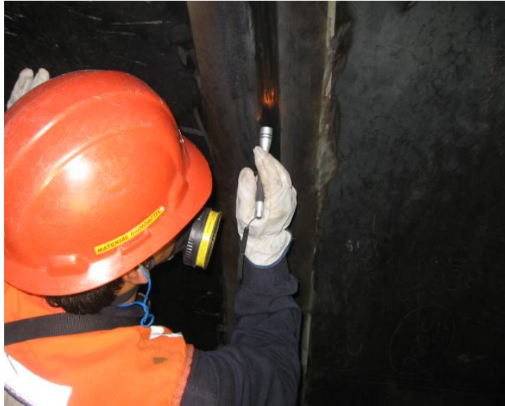
Fotografía N°5.2. Inspección visual de cordón de soldadura en tubería forzada.
