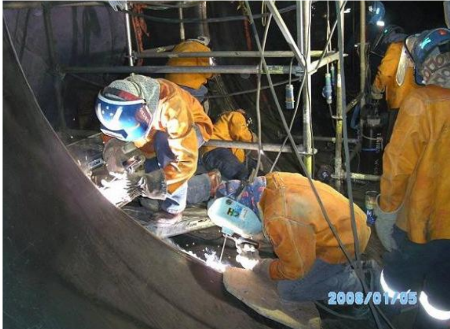
Fotografía N° 4.13 Soldadores Completamente Uniformados con Equipos de Protección durante el trabajo.
