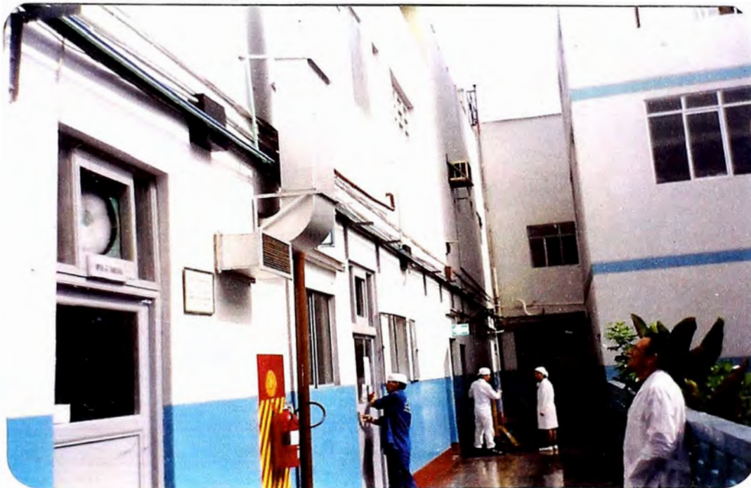
Recorrido de sub - alimentadores existentes
