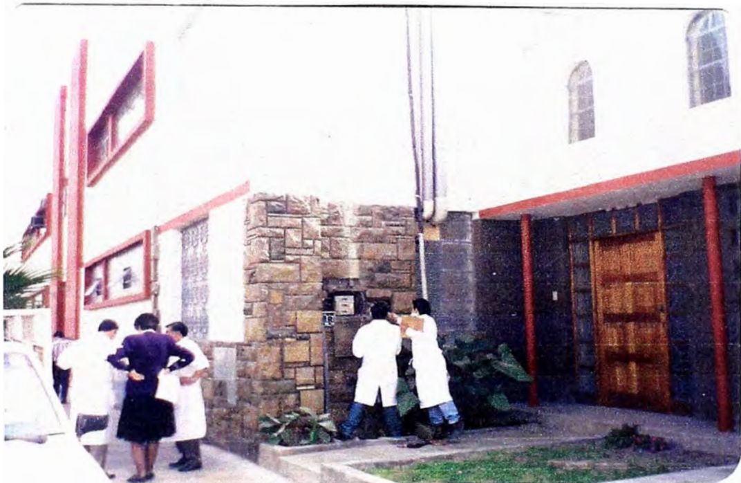
FOTO 2 Acometida existente - Vista exterior.
