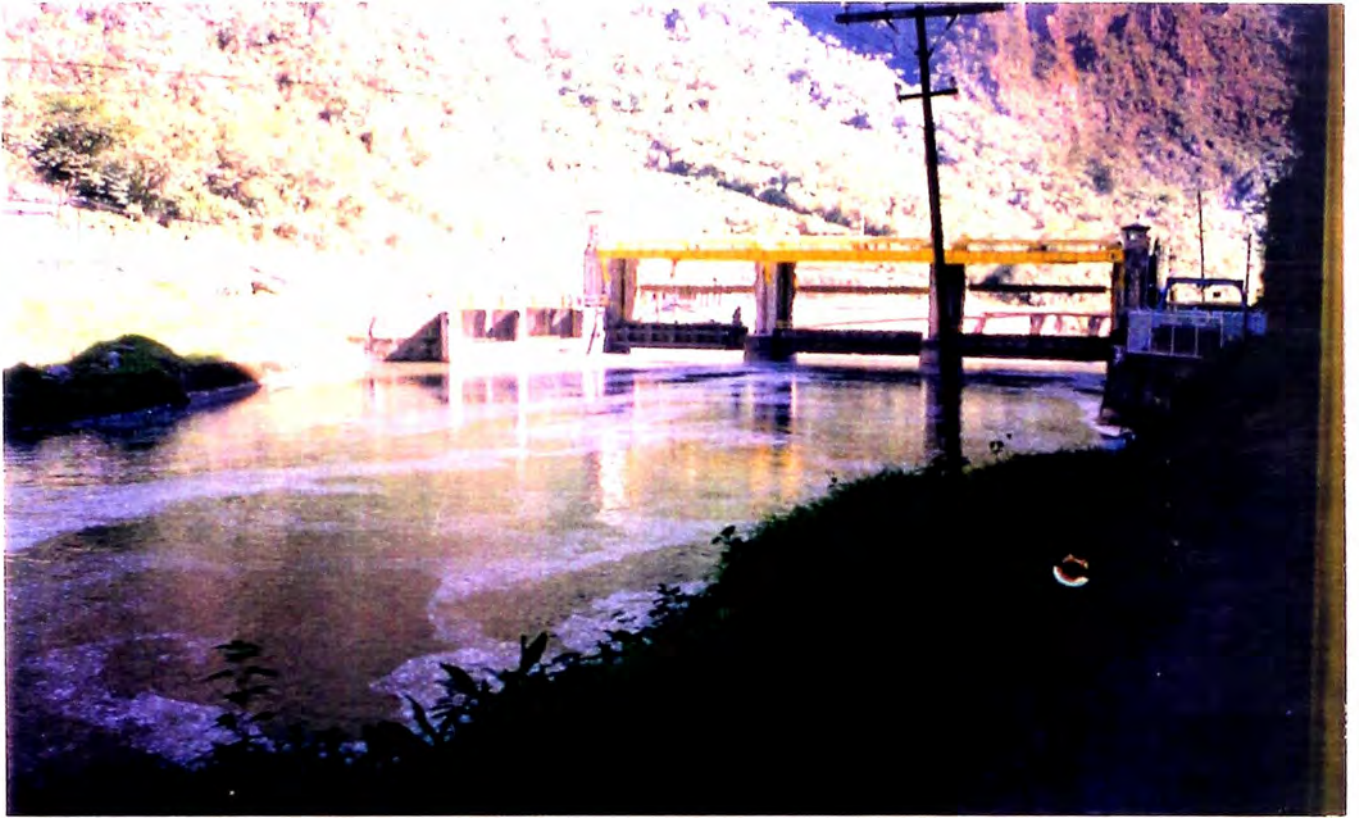
V-1: PRESA KM 107 CHM
