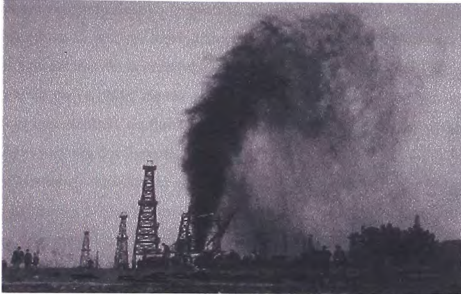
Foto 1.- Reventón en un pozo perforado en los Estados Unidos de Norteamérica, en el que se puede ver el flujo incontrolado de petróleo y gas hacia la superficie (Geoservices, 2003).
