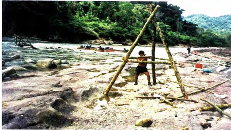
FOTO N° 13. CONSTRUYENDO "CABALLOS" PARA REPRESAR CAUCES TURBULENTOS, RIO NUSINISCATO
