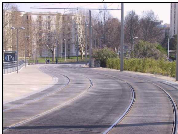
Figura N° 6. Curva en S en la que el movimiento del vehículo es más incierto, Montpellier. (Autor: F. Carrasco)
