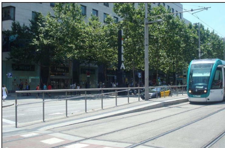
Figura N° 11. Rampa de acceso al andén, Barcelona
