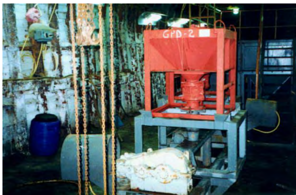
Fig. 24 Estación subterránea de tratamiento de agua de mina Polonia.
