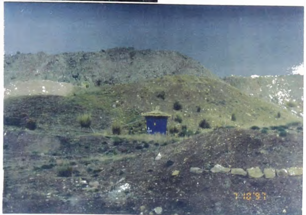
TANQUE DE AGUA POTABLE PERFIL DEL BOTADE- RO # 3 MIRANDO AL NORESTE
