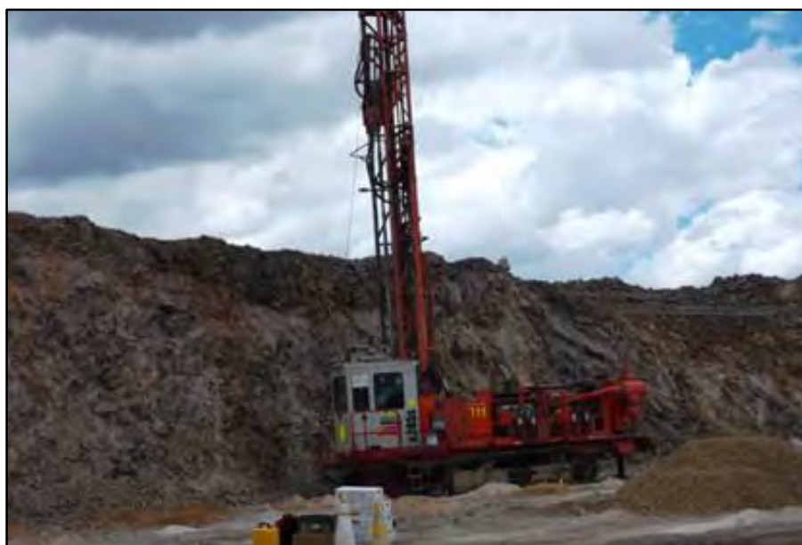
Fig. 2.1 Equipo de perforación SANDVIK - D245S
