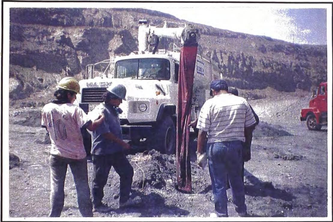
**FIG. 11 - 12 : Secuencias del carguío del APEXSA - HA.37, con manga de cuerina, en reemplazo del ducto original de descarga.**
