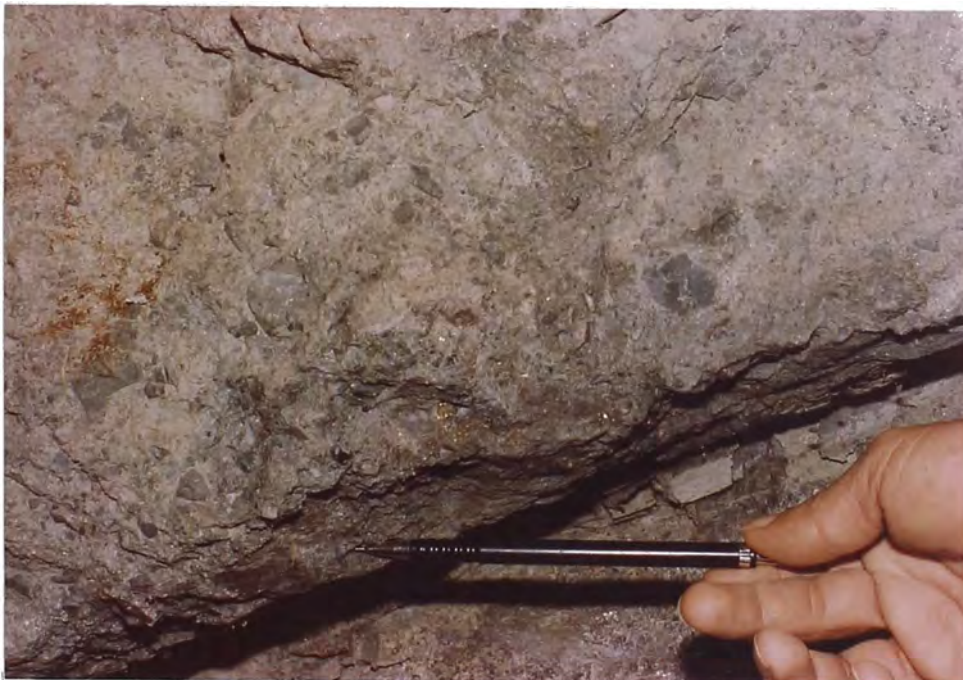
FOTO 6. Fallamiento inverso post-mineral (N-S/25°W), con brecha tectónica y mineral de arrastre, que desplaza 15 mts. a la veta principal. (ver plano 15).
