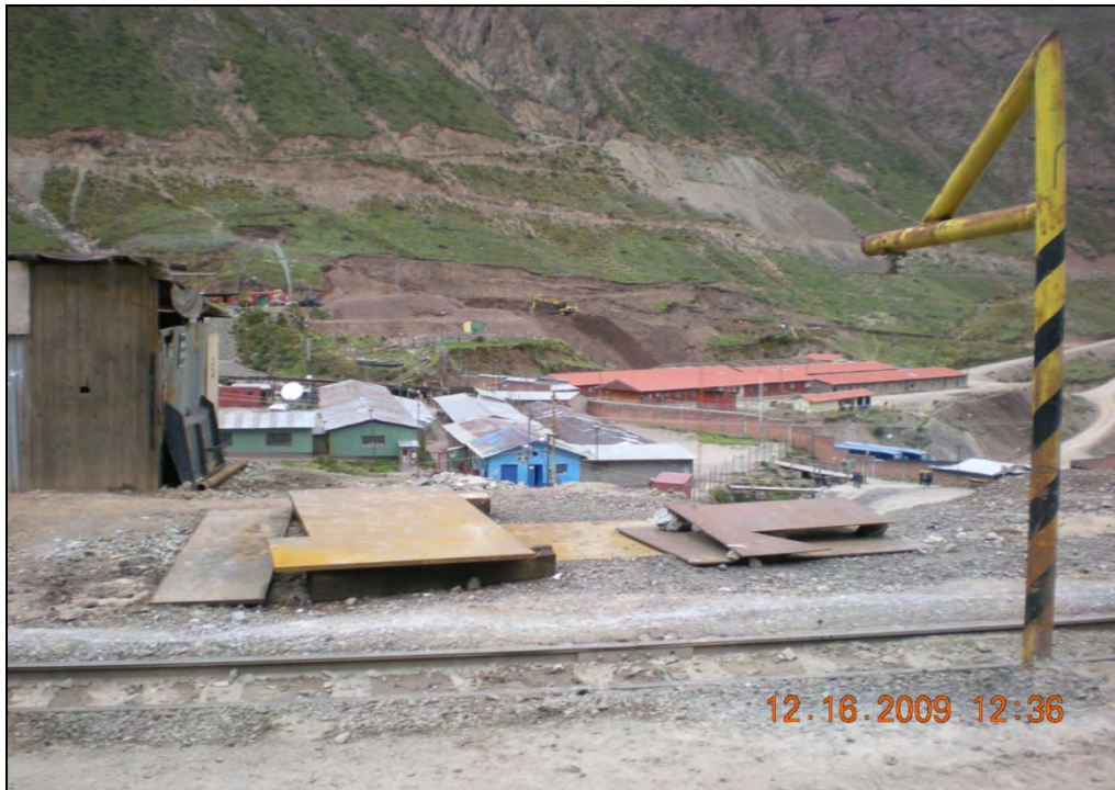
Fotografía N° III - 01: Falta de orden y limpieza
