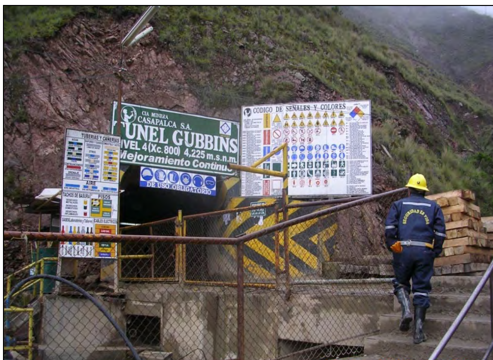
Fotografía N° III – 12: Patio de ingreso en Nivel 4 (Cx-800),
