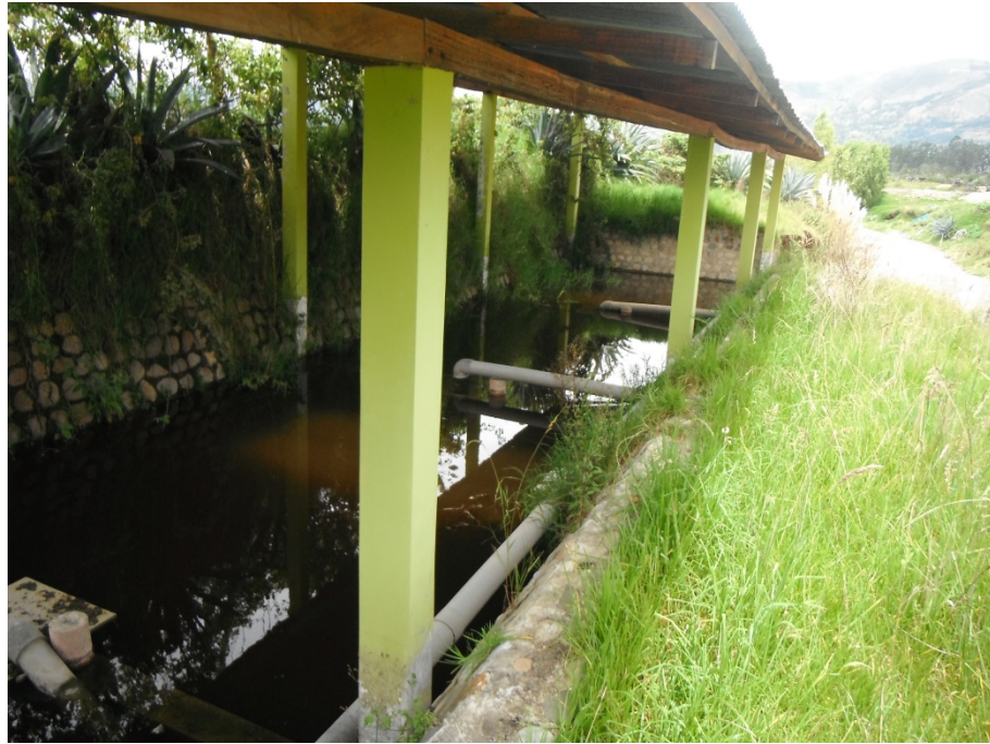
Imagen N° 2.3 - Lecho de Secado
