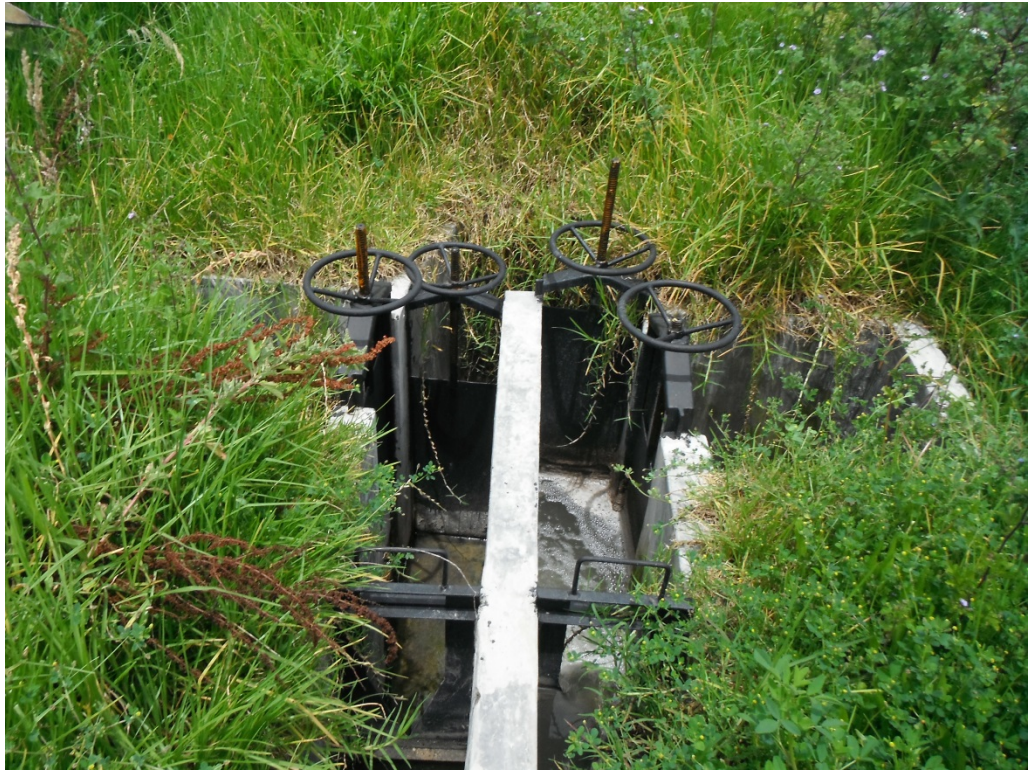
Imagen N° 2.1 - Estructura de Entrada
