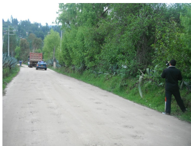
Imagen N° 3.4 - Vía hacia Quinuapata
