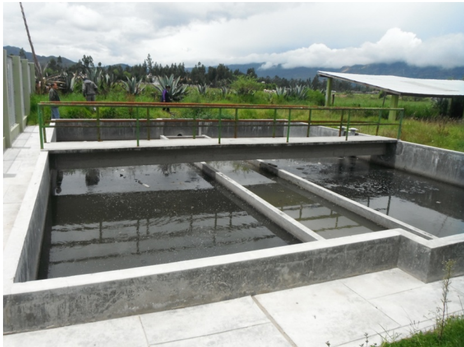
Imagen N° 2.2 - Tanque Imhoff
