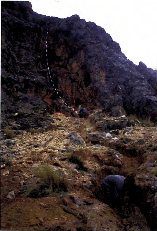
FOTO 5.3, mirando al NE: Trinchera T5 con rumbo N50°E ubicada en la base del cerro Incapachita (S del cerro Señal Incapacha). En la escarpa del afloramiento se ubica la estructura silícea con abundantes óxidos (rumbo N40°E), que corresponde a las muestras 51019 (6.6 grAu/TM) y 51020 (17.4 grAu/TM) respectivamente. El afloramiento es de intrusivo pórfido andesítico con alteración argílica avanzada en la base y sílice masiva al tope. Ver mosaicos 4.3 y 4.5.
