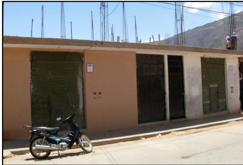
Figura 7.17.- Edificación de albañilería con un adecuado diafragma rígido.
