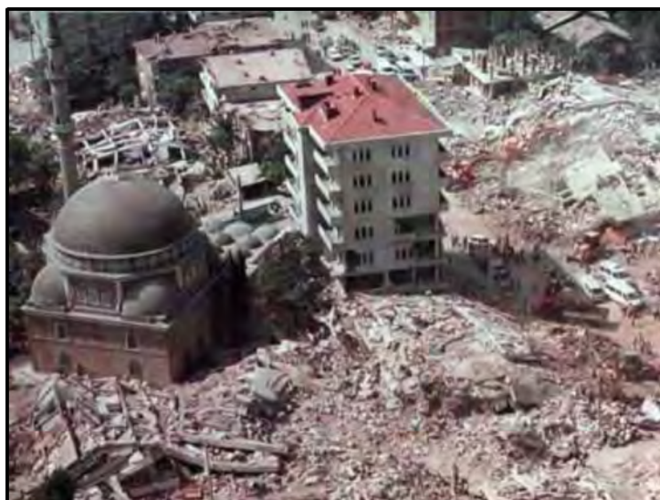
Figura 2.14.- Daño observado en las edificaciones luego del terremoto de Turquía del 23 de octubre del 2011.
