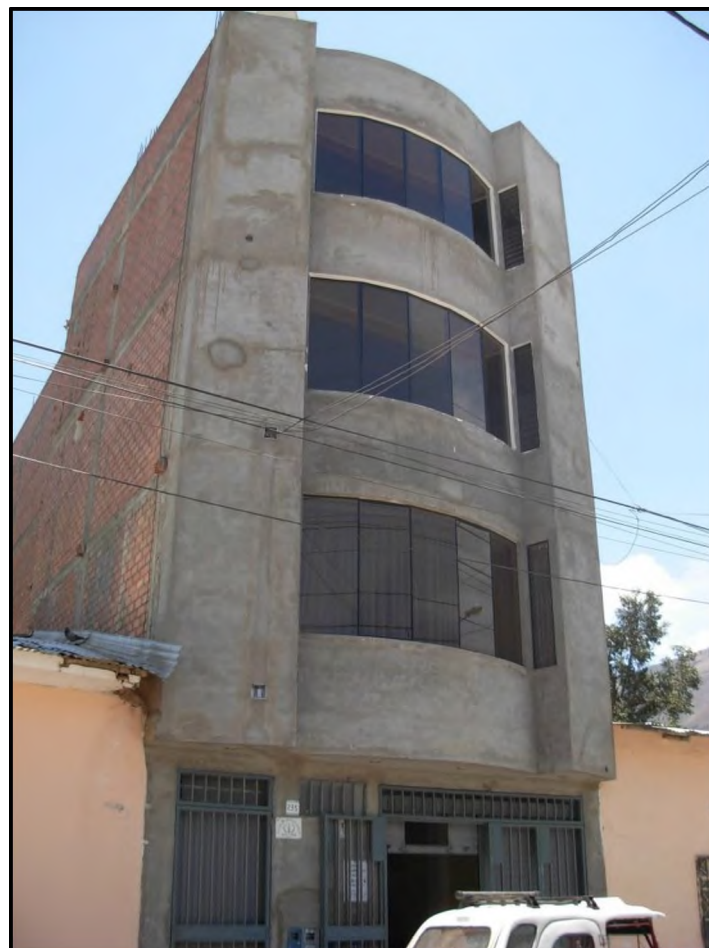
Figura 7.25.- Edificación con cubierta de losa aligerada.
