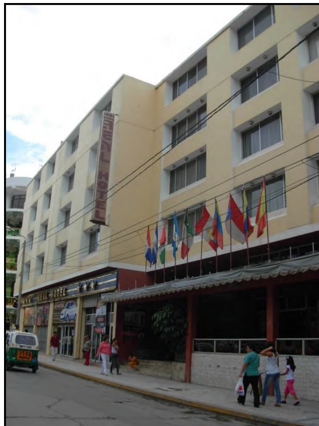
Figura 5.6.- Edificación de concreto armado con 30 años de antigüedad en buen estado de conservación.
