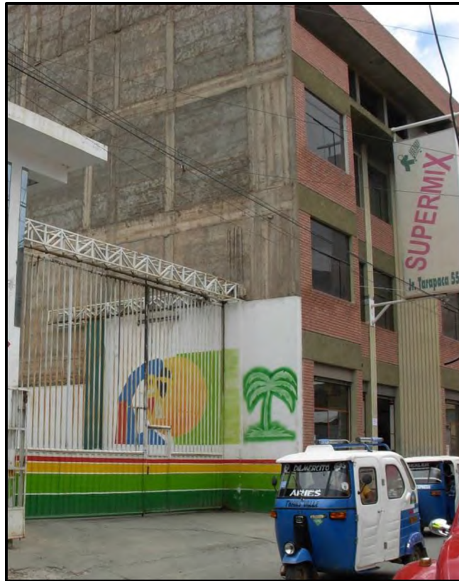
Figura 7.8.- Buena calidad del sistema resistente de concreto armado.
