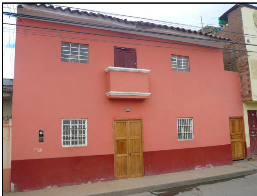
Figura 5.3.- Edificación de adobe de 2 niveles en regular estado de conservación con cobertura liviana de teja.
