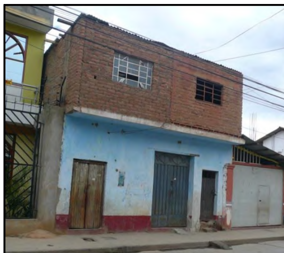
Figura 7.16.- Edificación de albañilería con diafragma rígido y cobertura liviana.
