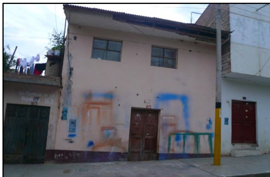
Figura 7.14.- Edificación emplazada sobre terreno con gran pendiente.
