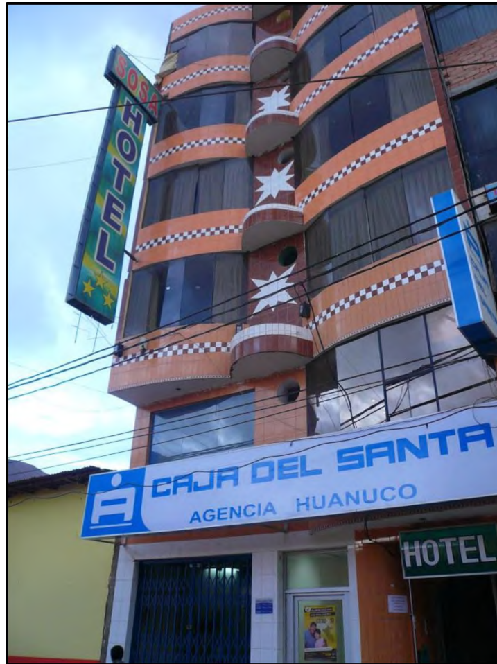
Figura 7.29.- Carteles publicitarios colocados en la fachada de la edificación.
