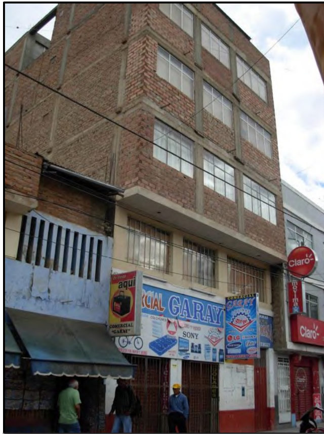
Figura 7.23.- Edificación con una adecuada distancia entre columnas.
