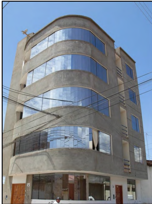
Figura 7.20.- Edificación de concreto armado con una adecuada distribución de masas.
