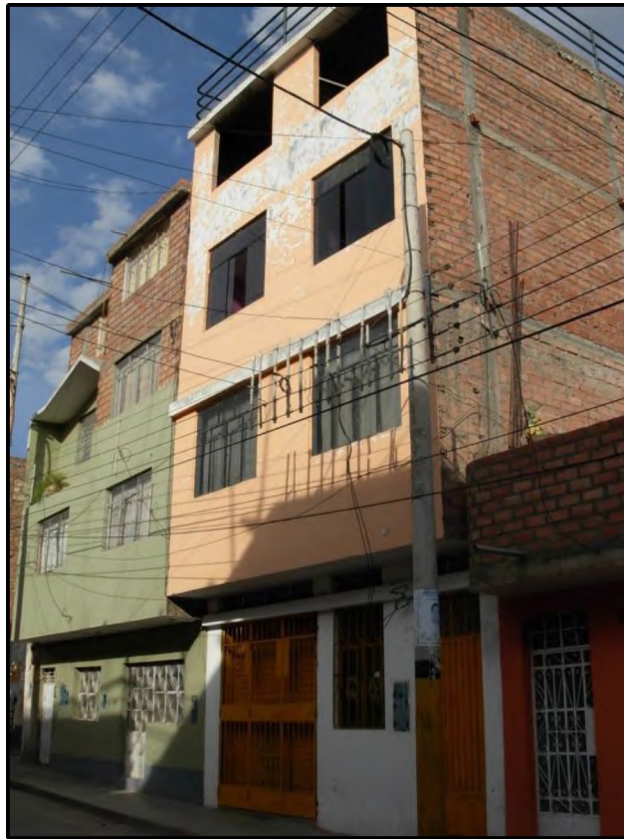
Figura 7.3.- Edificación de Albañilería adecuadamente confinada.
