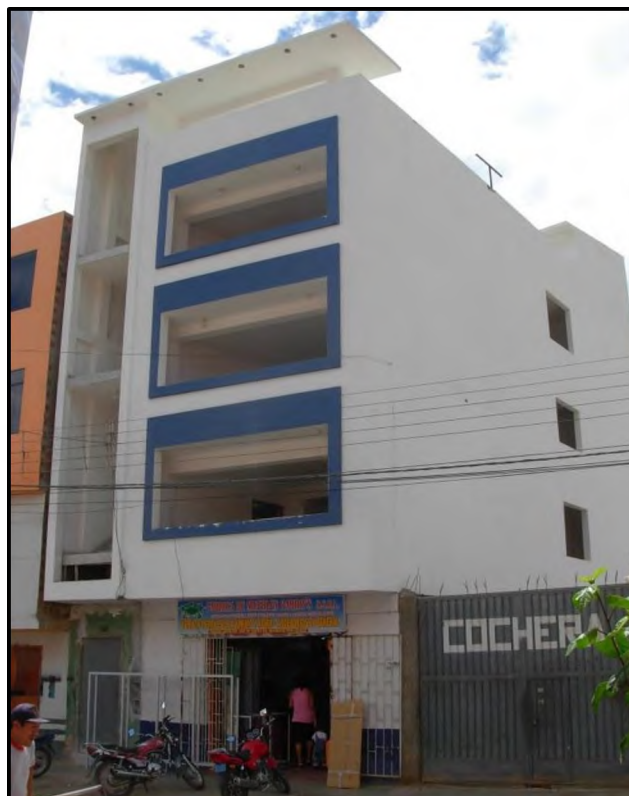
Figura 7.12.- Edificación de concreto armado con una adecuada cantidad de elementos estructurales.
