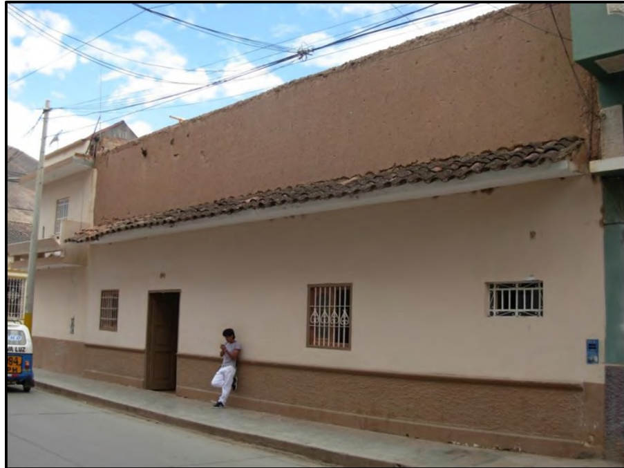
Figura 7.9.- Edificación de adobe sin una adecuada cantidad de muros ortogonales.
