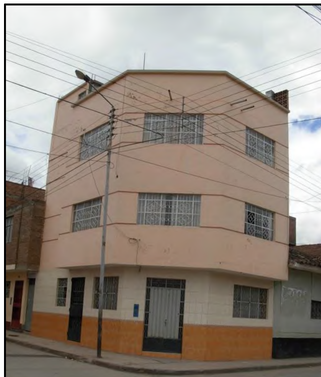
Figura 7.19.- Edificación de albañilería con una adecuada distribución de masas.
