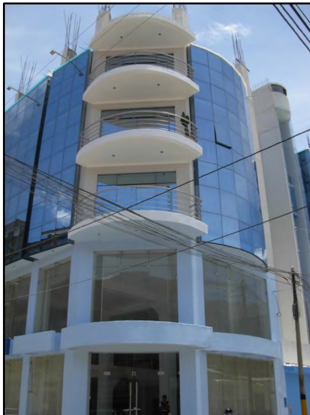
Figura 7.4.- Edificación de concreto armado con un adecuado sistema resistente.
