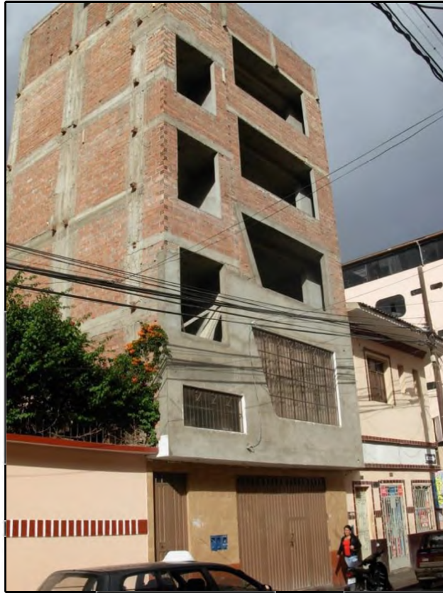
Figura 7.11.- Edificación con una adecuada cantidad de elementos estructurales y muros de albañilería.
