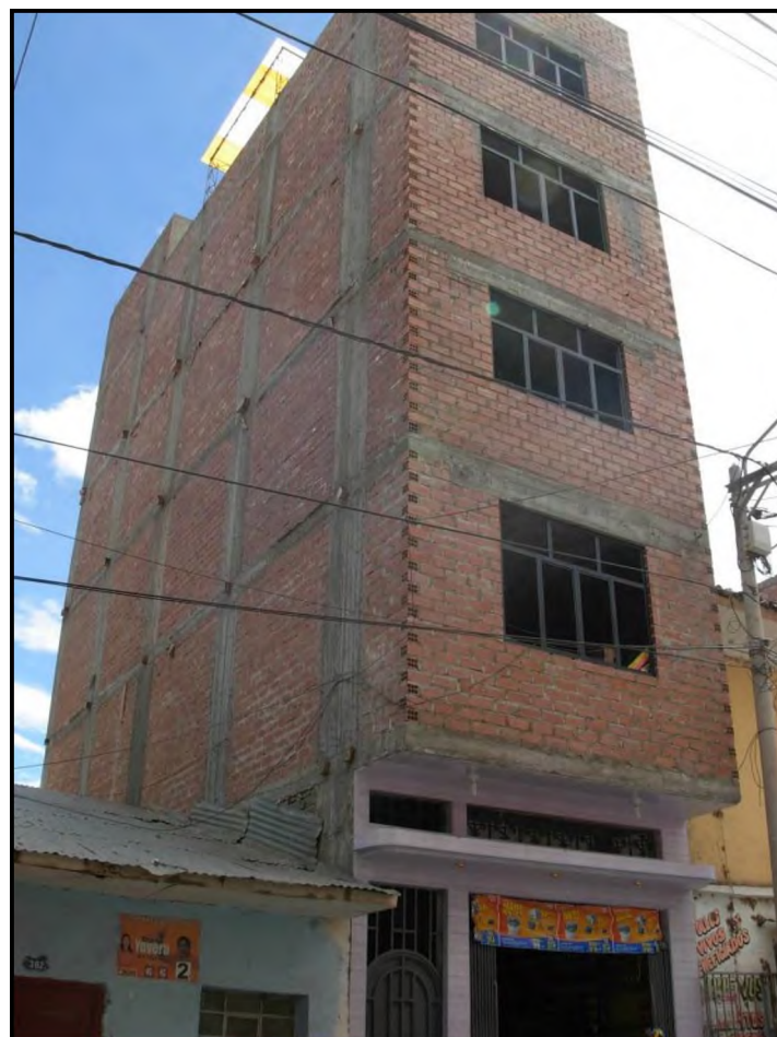
Figura 7.7.- Buena calidad del sistema resistente y unidades de albañilería.
