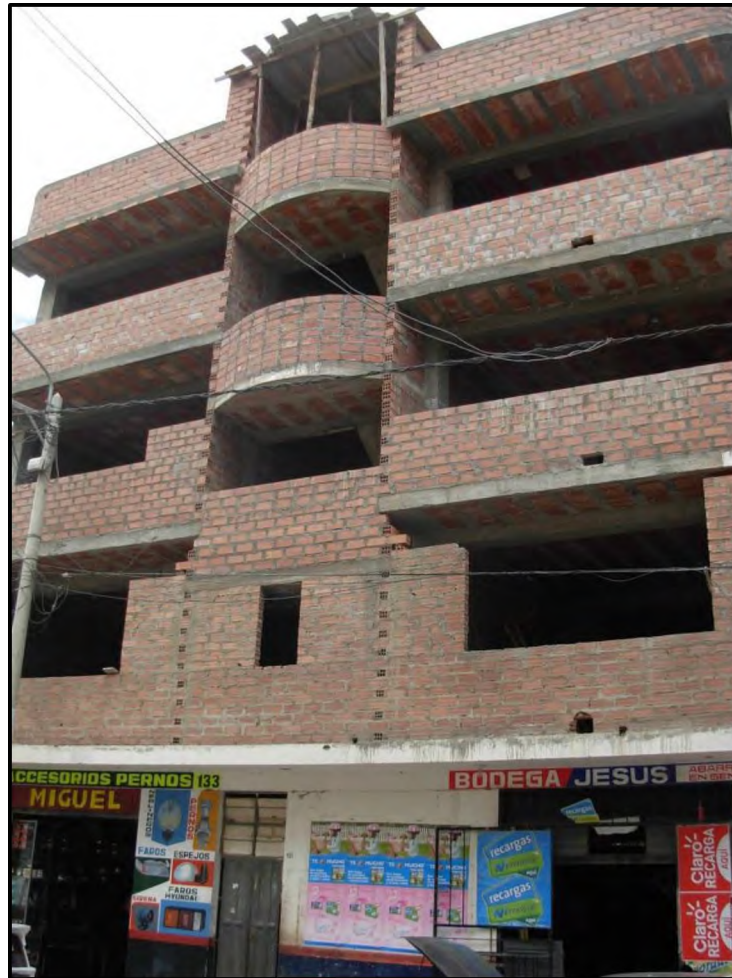
Figura 7.27.- Edificación de albañilería con parapetos no confinados.
