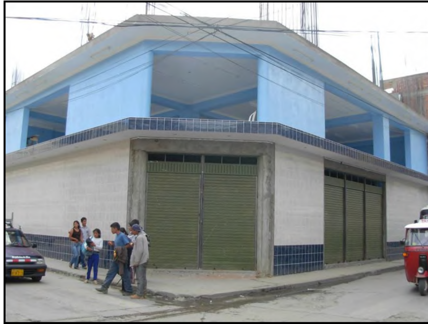
Figura 5.5.- Edificación con columnas, vigas y muros de concreto armado con 3 años de antigüedad en buen estado de conservación.
