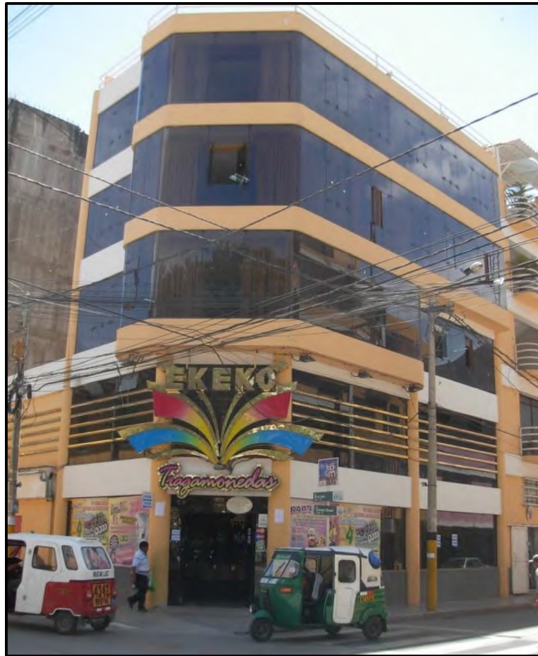
Figura 7.32.- Edificación de concreto armado en buen estado de conservación.
