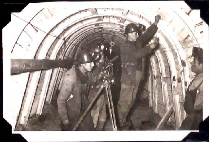
Foto 18.- Arcos simples en galería principal. Topógrafos colocando punto.
