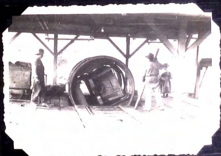
Foto 27.- Vaciadero neumático, volcando un carro de carbón.
