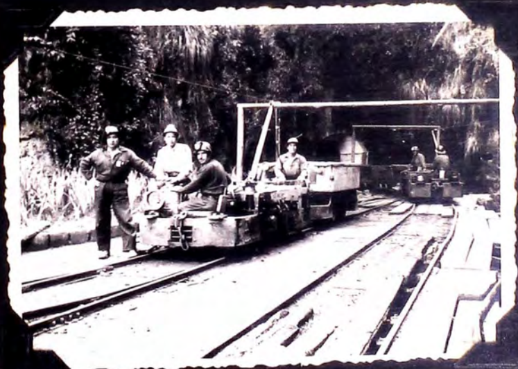
Foto 24- Locomotoras: de trolley y de batería, esperando para entrar al Túnel Pacará; y otro de trolley saliendo.
