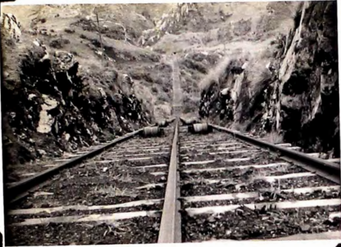
Foto 29.- Inclinado de Pucará. Vista de la parte alta, vea se al fondo uno de los túne- les del Inclinado.
