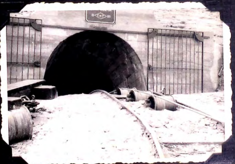
Foto 16.- Bocamina Pique Chapur. Acceso eventual de reciente construcción. Los carros en el fondo del Pique
