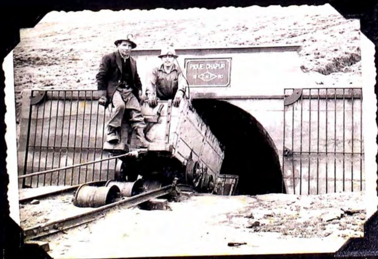
Foto 17.- Pique Chapur. Carros mineros izados con el personal de Supervisión.
