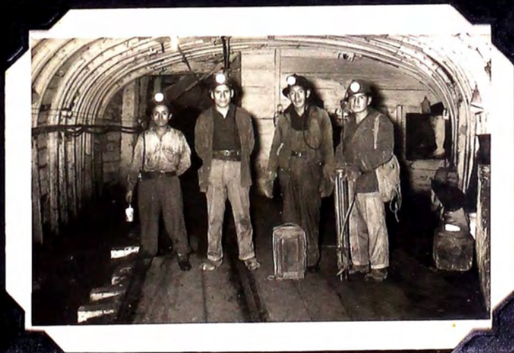
Foto 19.- Arcos suplementarios en una estación. Topógrafos de paso por el lugar.
