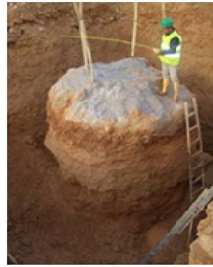
Figura 5-16: Columnas de SúperJet Grouting en arcillas firmes
