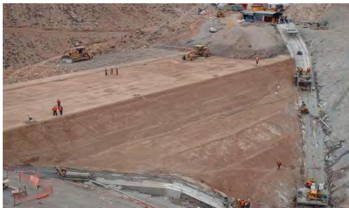
Figura 4-30: Longitud de la capa de concreto donde se construirá la cortina de inyecciones
