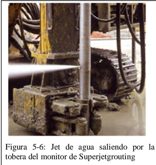
Figura 5-6: Jet de agua saliendo por la tobera del monitor de Superjetgrouting
