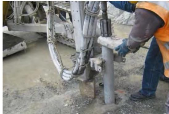
Figura 6-6: Instalación de niple de acero para el control de inyecciones de contacto
