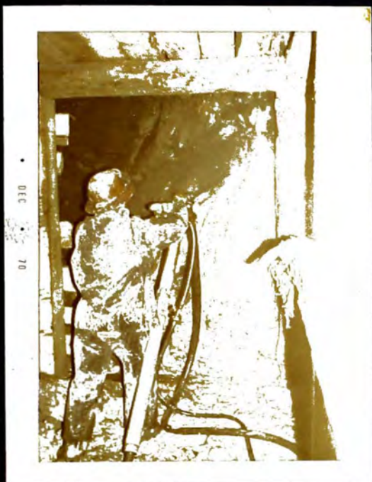
Perforista operando una máquina Puma BBC 16 W ↳
