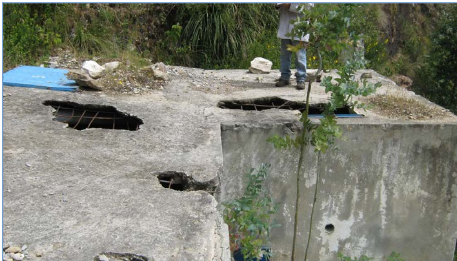
Foto 3. Planta de Tratamiento de Agua Potable
