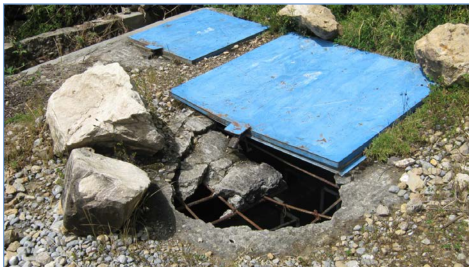
Foto 4. Planta de Tratamiento de Agua Potable
