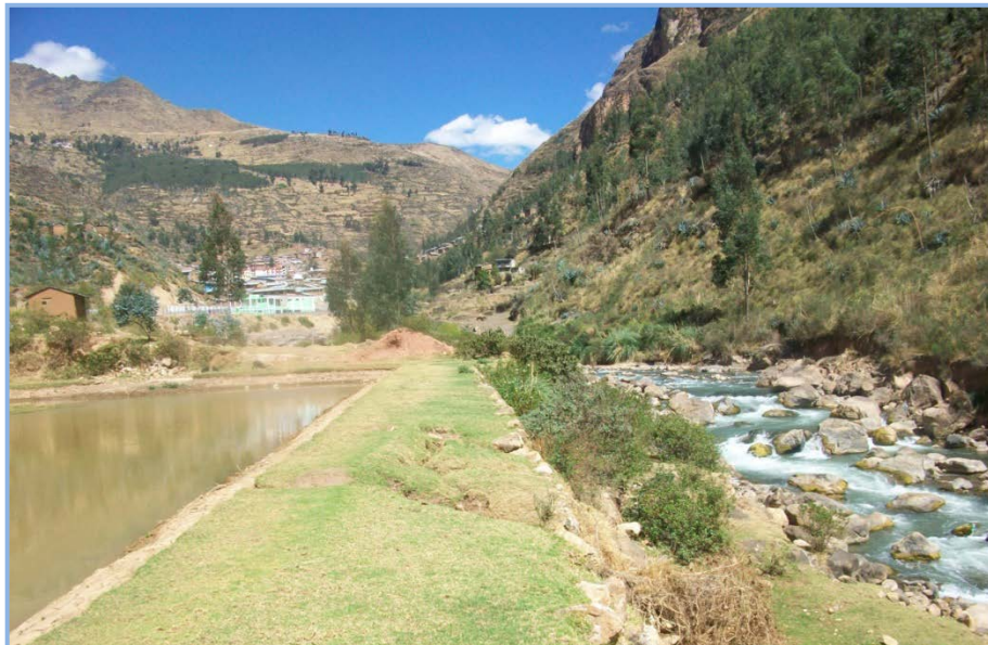
Foto N°6. Vista de la laguna facultativa de la PTAR y el río Chaupihuaranga, cuerpo receptor del efluente de la planta de tratamiento.
