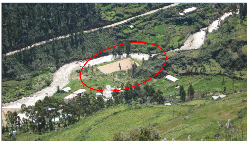
Foto 9. Planta de Tratamiento de Aguas Residuales
