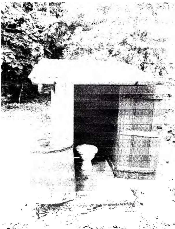
Fotografía N° 10: Letrina de arrastre hidráulico, FONCODES – Loreto. Utiliza un tanque de ferrocemento para Almacenar el agua de lluvia.
