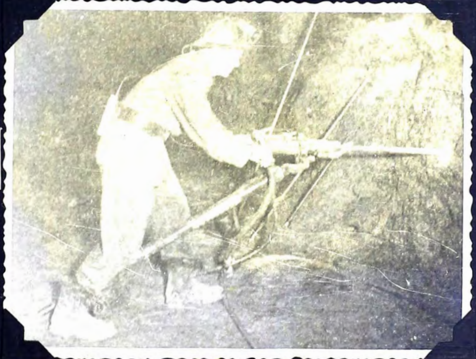
Figura 2.2.- Perforado- ra jäckleg o jäckdrill
