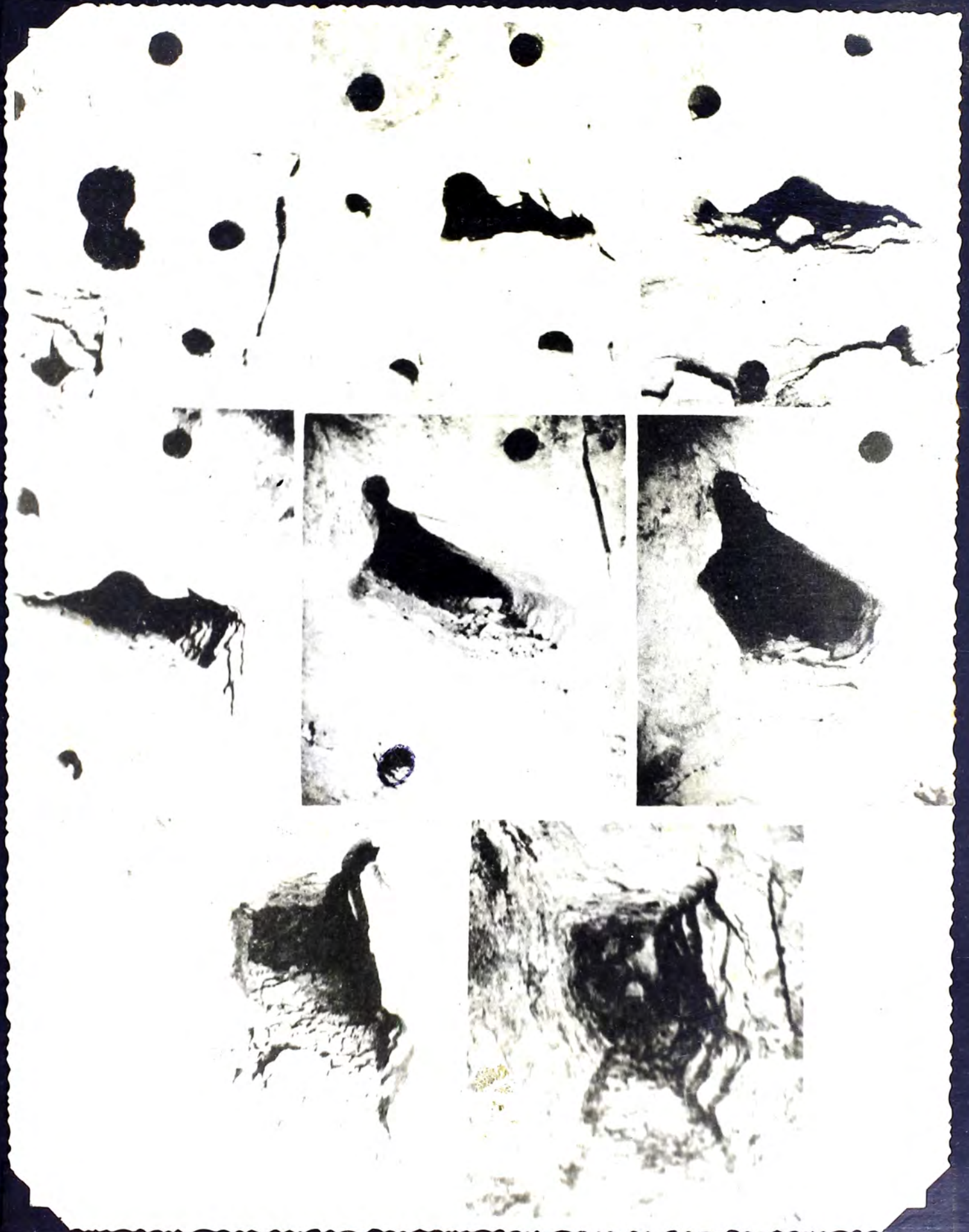
Figura 3.5.- Voladura de un erranque coromant. Fila superior, de izquierda a derecha; antes de la voladura y después de la salida de los taladros 1 y 2. Fila intermedia: después de la salida de los taladros 3, 4, 5. Fila inferior: al salir el taladro 6 y después de haberse limpiado.
