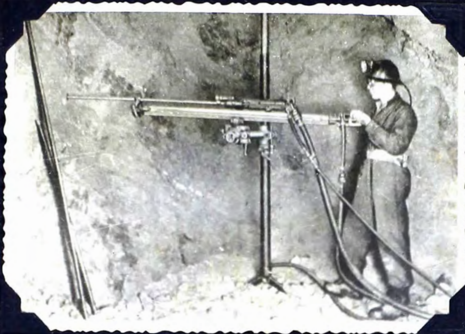
Figura 2.1.- Montura de columna
