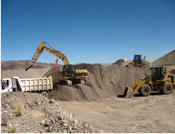
Se Realiza la Explotación y Producción del Material de la Cantera del Km 56+700. Se hace controles según Normas
