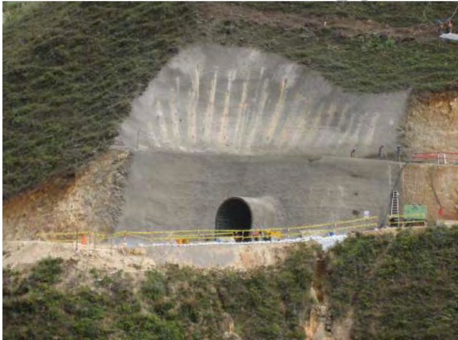
Fotografía 3: Vista panorámica del falso túnel
