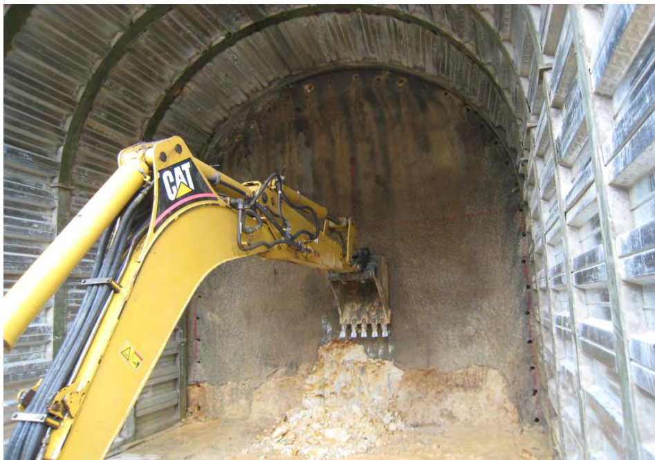
Fotografía 4: Vista interna del falso túnel y primera excavación del túnel
