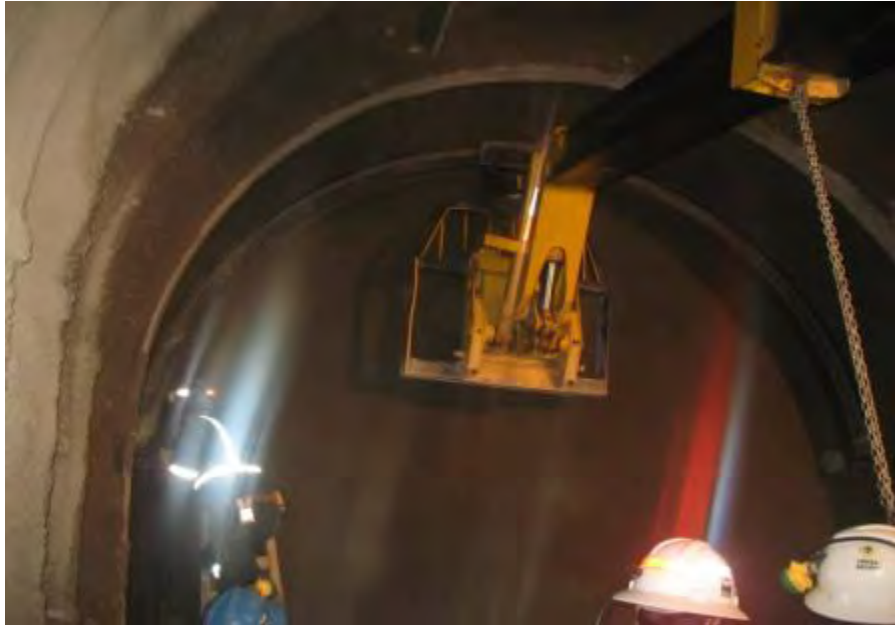
Fotografía 6 Elevación del arco de acero
