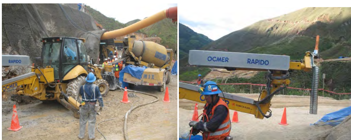
Fotografía 9 Equipo para aplicación de shotcrete
