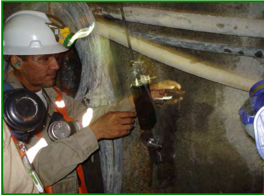
Fotografía 11: Medición de convergencia en la progresiva 0+205
