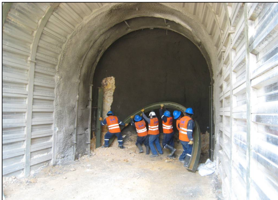
Fotografía 5 Instalación de arco de acero
