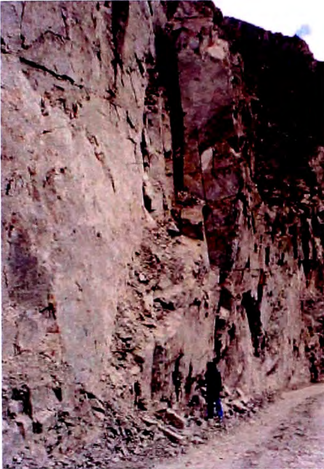
Foto N° 7.1 Caída de rocas a la altura del Km 12 de la carretera Huampara-Pilas
