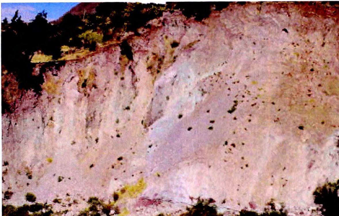
Foto N° 7.4 Derrumbe ubicado en las afueras de la ciudad de Sangallaya, a la altura del Km 0.8 de la Sangallaya-San Lorenzo de Quinti. Afecta a esta carretera en un tramo de 100 m.
