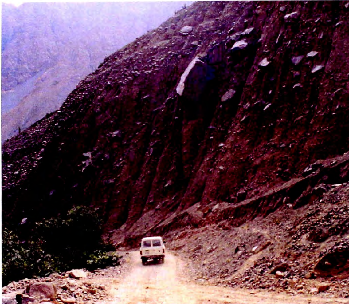
Foto N° 7.3 Caida de rocas en el Sector Pongo, a la altura del Km 15 de la carretera Cayahuasi-Viscas. Se observa los bloques suspendidos, en ladera de pendiente abrupta.
