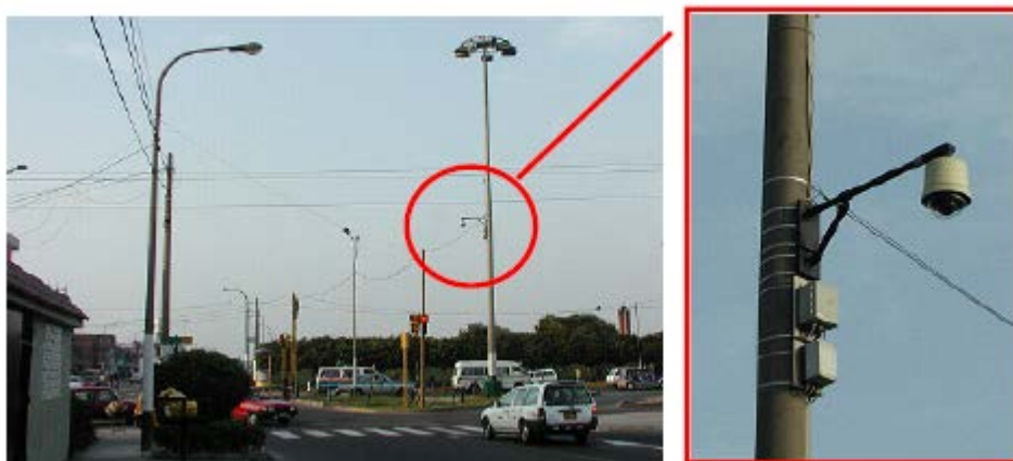
Figura 9.3.3-2 Sensor de Micro-ondas con Detector Remoto (RTMS) con Cámara con Auto Vídeo
