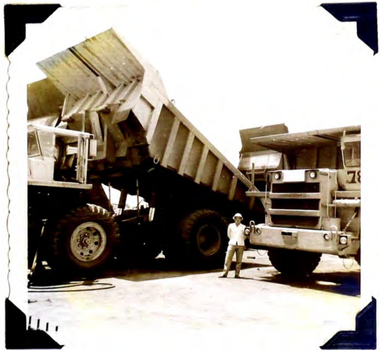
Camiones de 40 y 42 c.y. usados para el carguío de mineral en el área de la mina.
