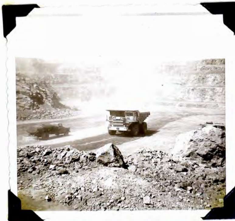
Vista parcial de la mina # 5, donde se puede observar el sistema de gradines variables usados en la explotación.
