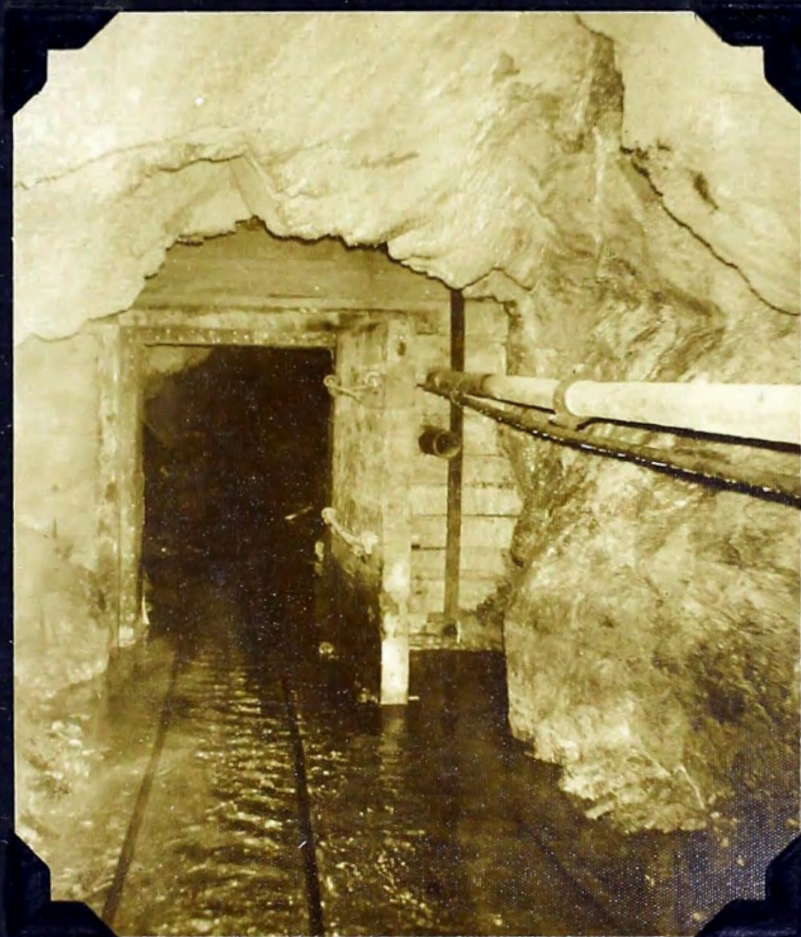
Fotog. N° 7. NIVEL 1300 Compuerta de seguridad.
