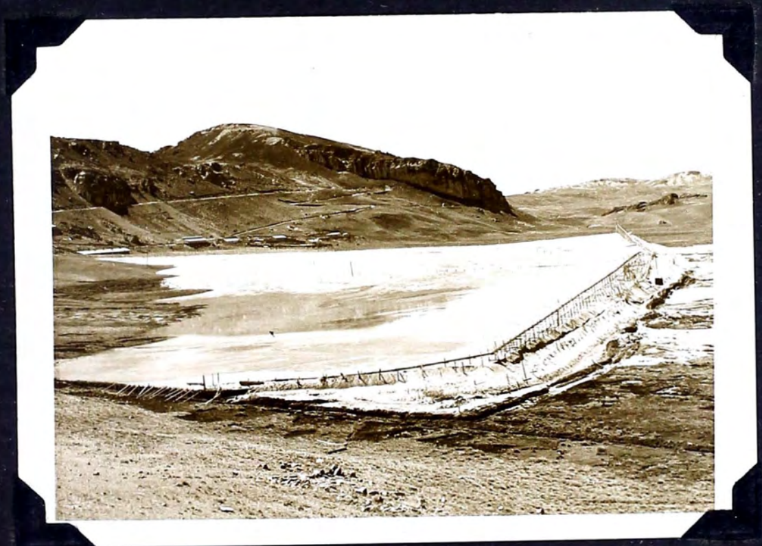
Fotografia N°11. Cancha de Relaves.
