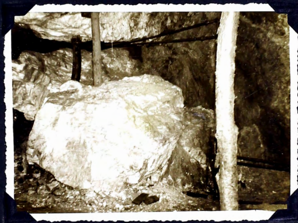
Fotog. N°6._ TAJEO 1608: Sostenimiento por medio de puntales.
