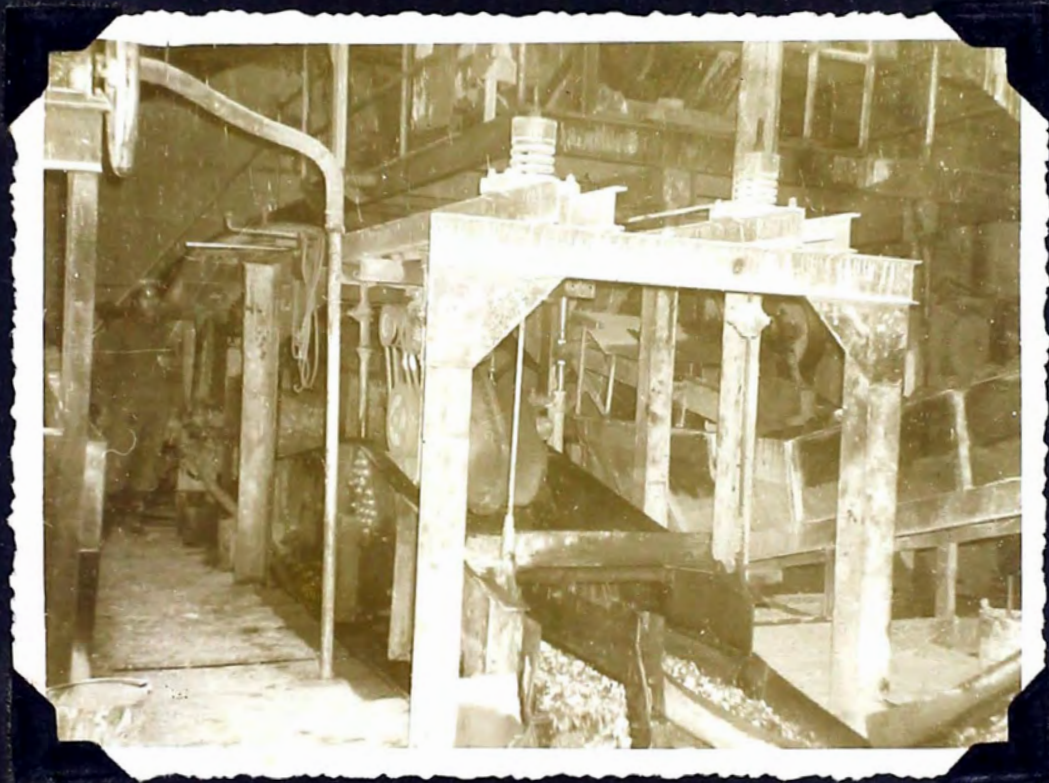
Fotog. N° 9. Instalaciones del Sink and Float.
