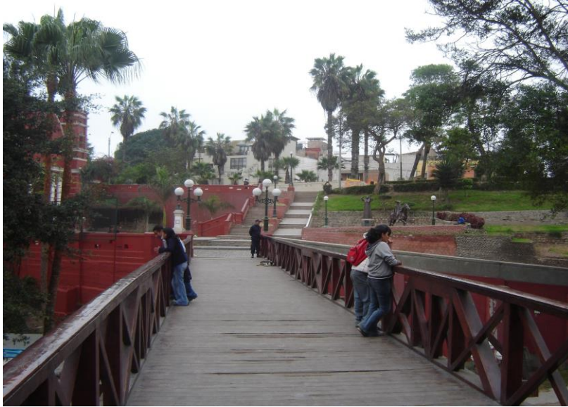
PUENTE DE LOS SUSPIROS DE BARRANCO
