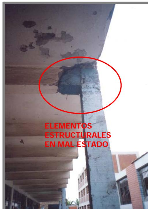
C.E. 3033: Construcción antigua muestra el encuentro de viga – columna en mal estado.
