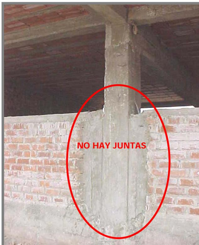
C.E. 3082: El módulo está en construcción; sin embargo se observa que no se dejaron las juntas necesarias para evitar el problema de columna corta. Esto evidencia la ausencia de personal técnico calificado.
