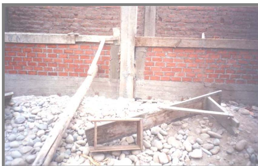
C.E.I. 313: Aun cuando se trata de una construcción nueva, las juntas son insuficientes y se repetiría el problema de columna corta.
