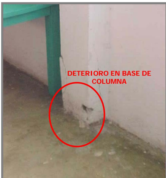
C.E.I. 338: Se observó deterioro en la base de algunas columnas.
