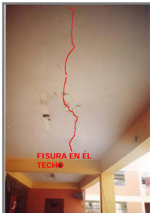
C.E. 3035: Se observa fisuras en el techo.
