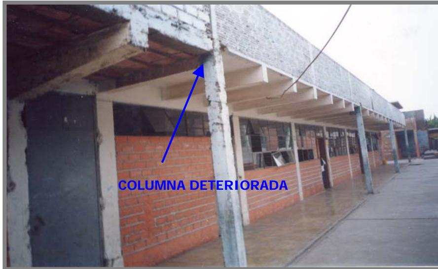
C.E. 3033: Construcción antigua (1963) con columnas seriamente deterioradas.
