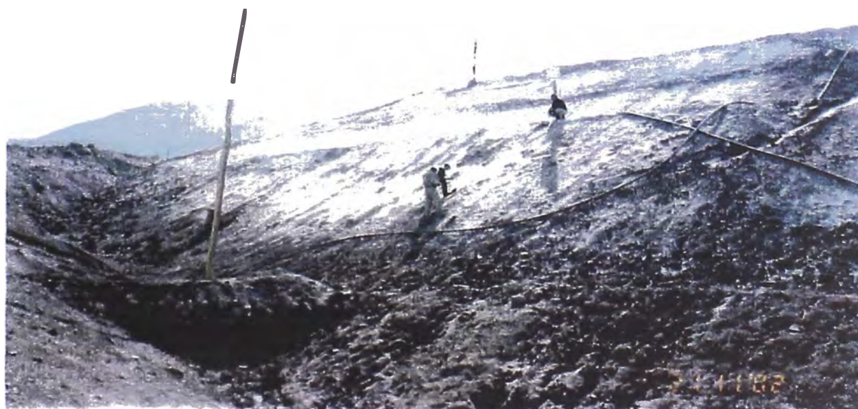
Foto 33.- Medición del talud terraplén frontal de la cancha de relaves
