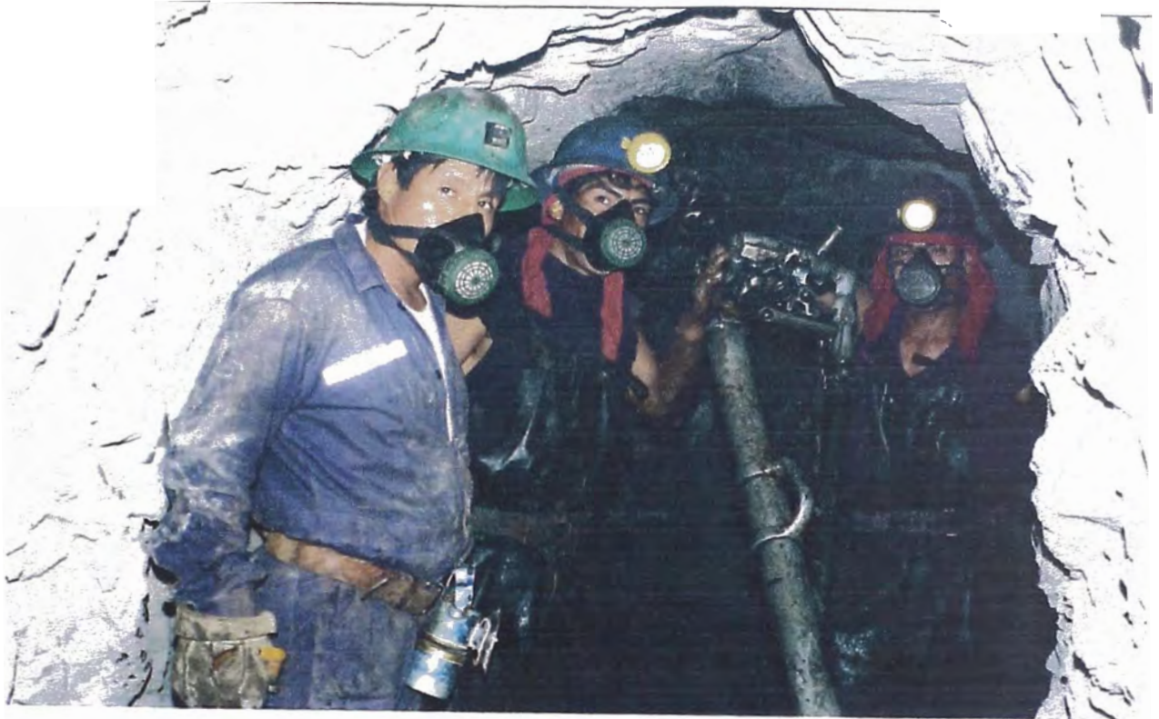
Foto 16.- Mina San Juan, listo para la perforación.
