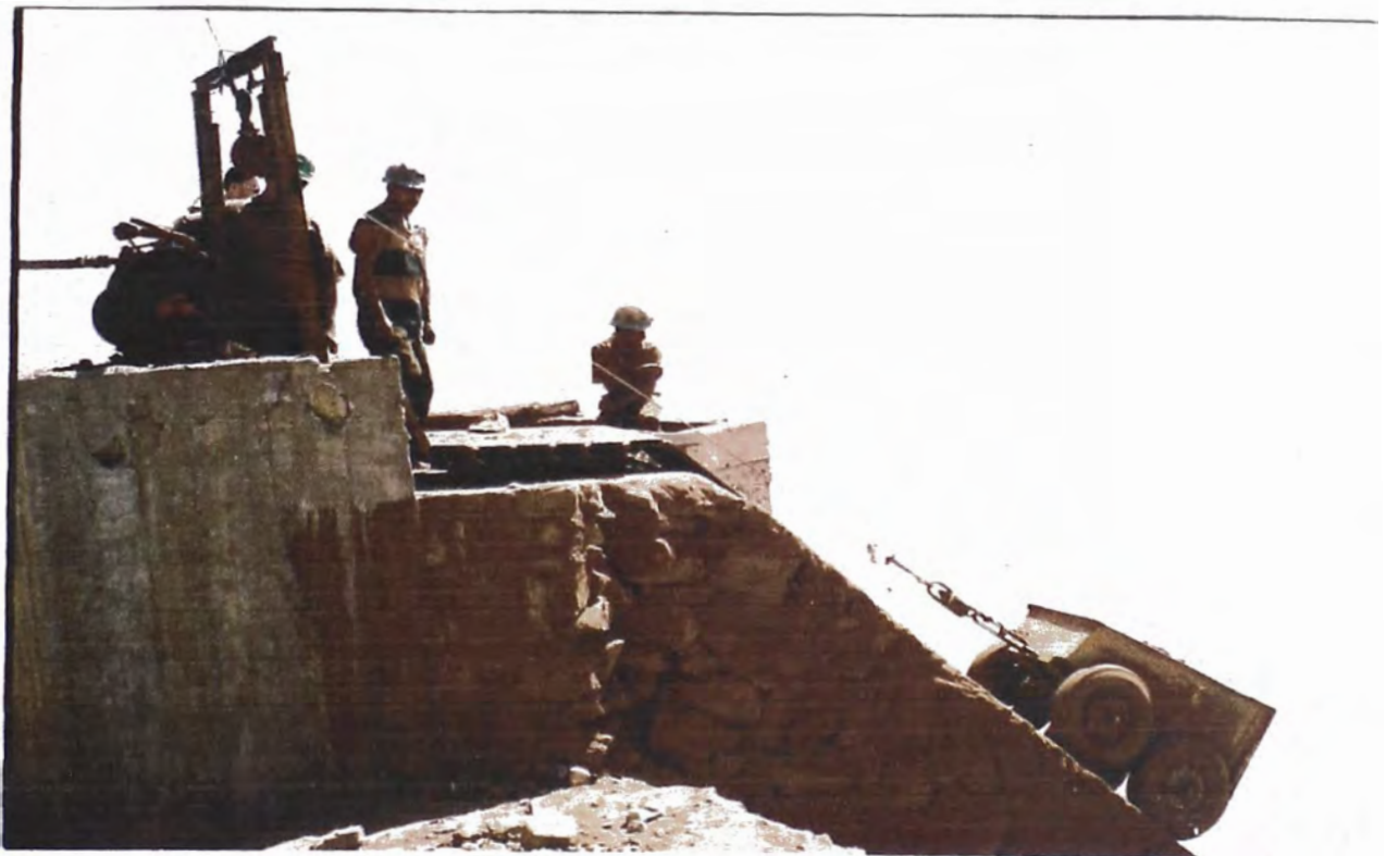
Foto 17.- Izaje de mineral del nivel 2040 al 2070, veta Esperanza.
