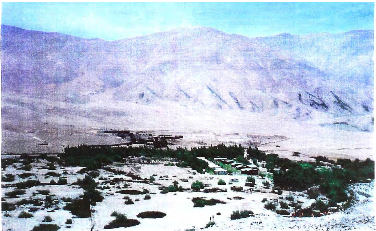
Foto 78.- Vista panorámica del campamento, planta y relavera, rodeado de vegetación.
