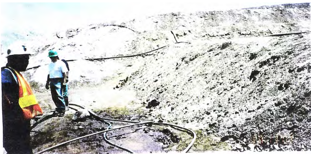
Foto 60- Material de préstamo, usado en la construcción de diques.
