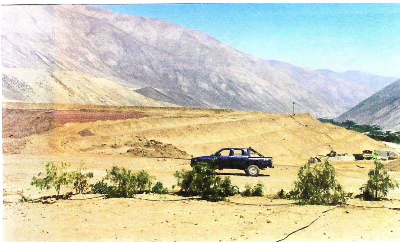
Foto 61.- Deposito de relaves, se ve al huaranguillo como cerco perimétrico.
