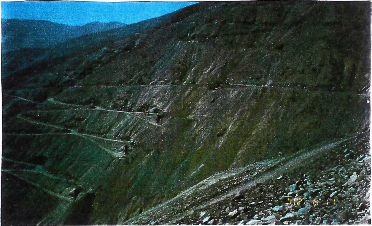
Foto 15.- Recolección de residuos sólidos de los taludes
