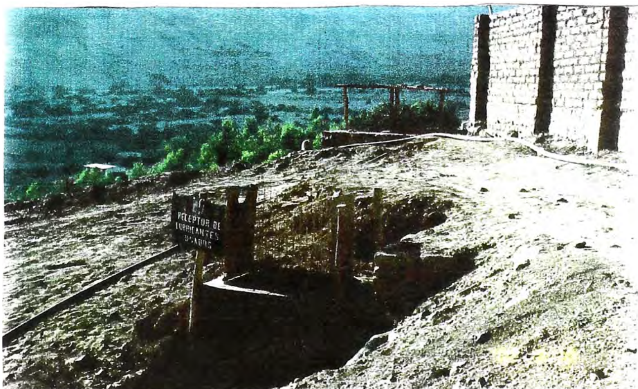
Foto 72.- Tanque receptor de lubricantes usados.
