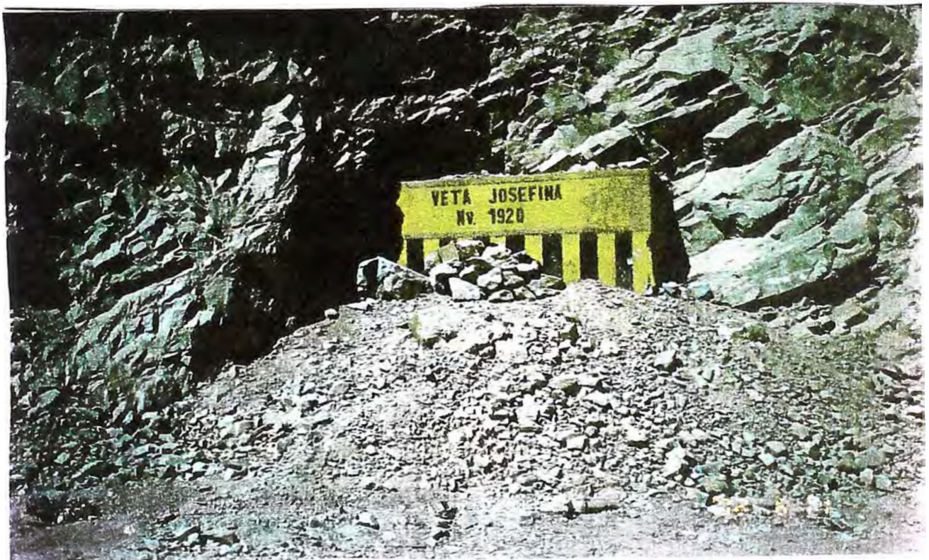
Foto 63.- Taponeo de bocamina para evitar su uso como letrina.
