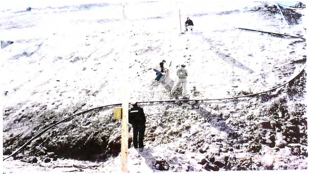
Foto 59.- Medición del talud aguas abajo terraplén frontal de la cancha.
