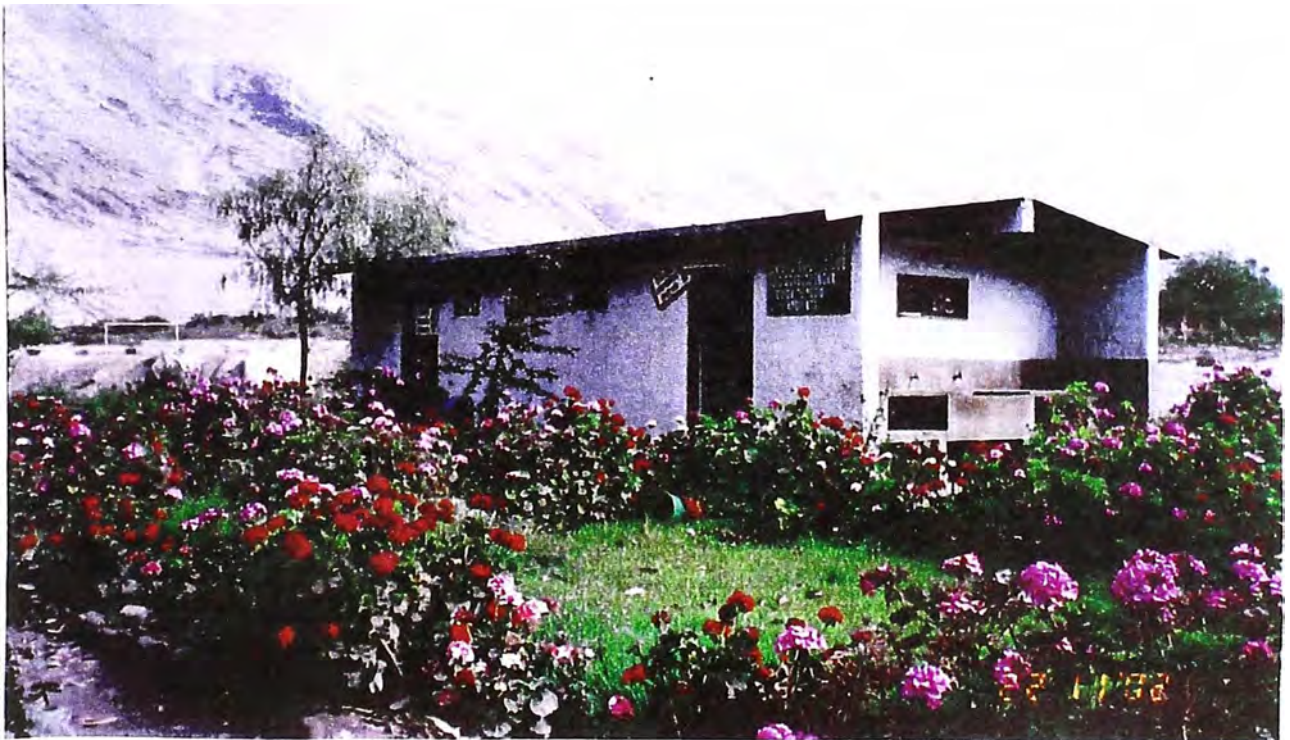
Foto 74.- Servicios higiénicos para el personal obrero del campamento.
