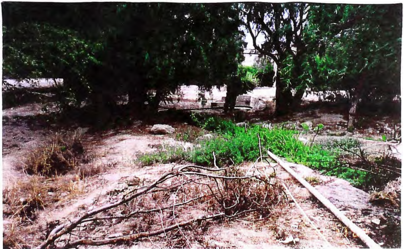
Foto 14.- Tendido de tubería de conducción de agua para consumo
