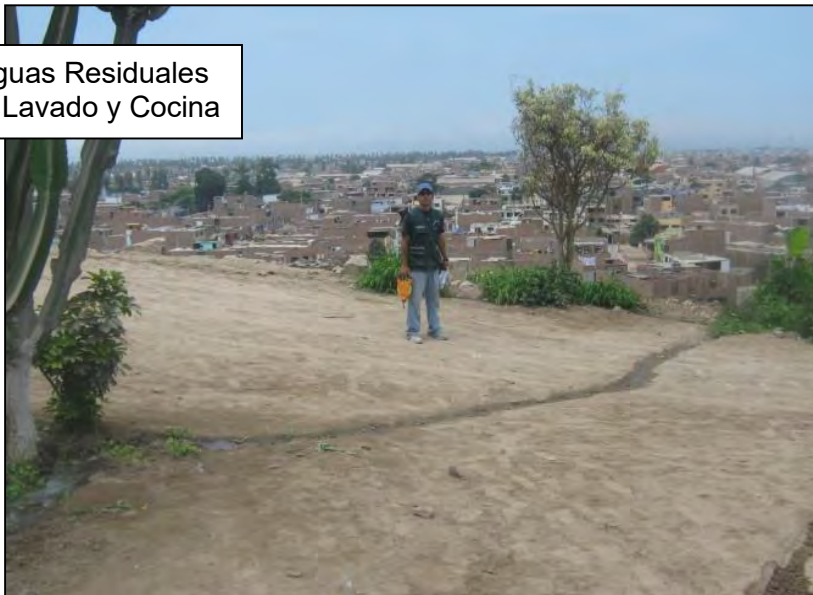
Foto N°2.0 Formación de canaletas para las aguas residuales
