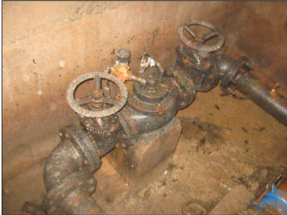
Foto N°5.0 Estado de las Instalaciones Hidráulicas de la CRP N°1
