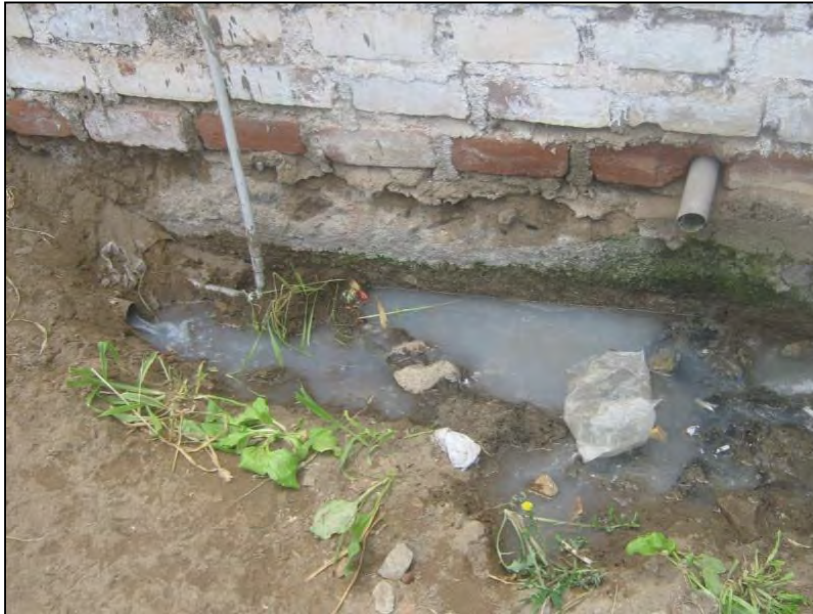
Foto N°2.0 Formación de canaletas para las aguas residuales
