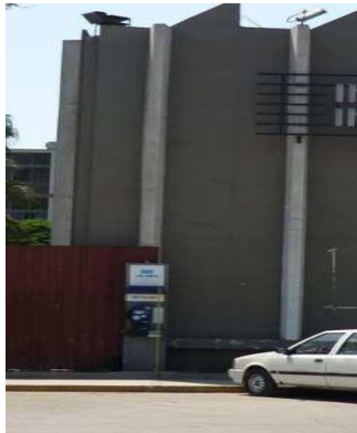
Fig. 7 Frontis de la Facultad de Ing. Industrial.
