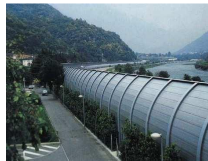
Fig. 10 Detalle del lado posterior de la barrera voladiza, la cual sería vista desde el interior de la ciudad Universitaria.
