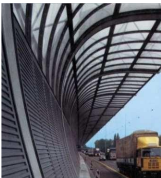
Fig. 8 Detalle de la barrera voladiza.
