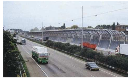
Fig. 9 Vista de la barrera voladiza, no altera el paisaje y crea una sensación de modernidad.
