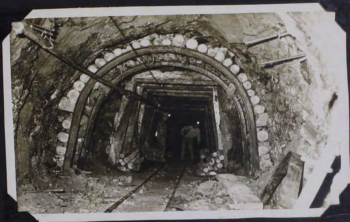
CON ARCOS DE RIELES DE 70 LIBRAS Y CON CUADROS DE MADERA DE EUCALIPTO
