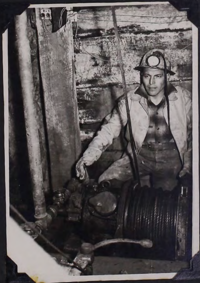
WINCHE PARA TRANSPORTE DE MATERIALES EN LA SECCION DE SAN MIGUEL DE MINA MOROCOCHA
