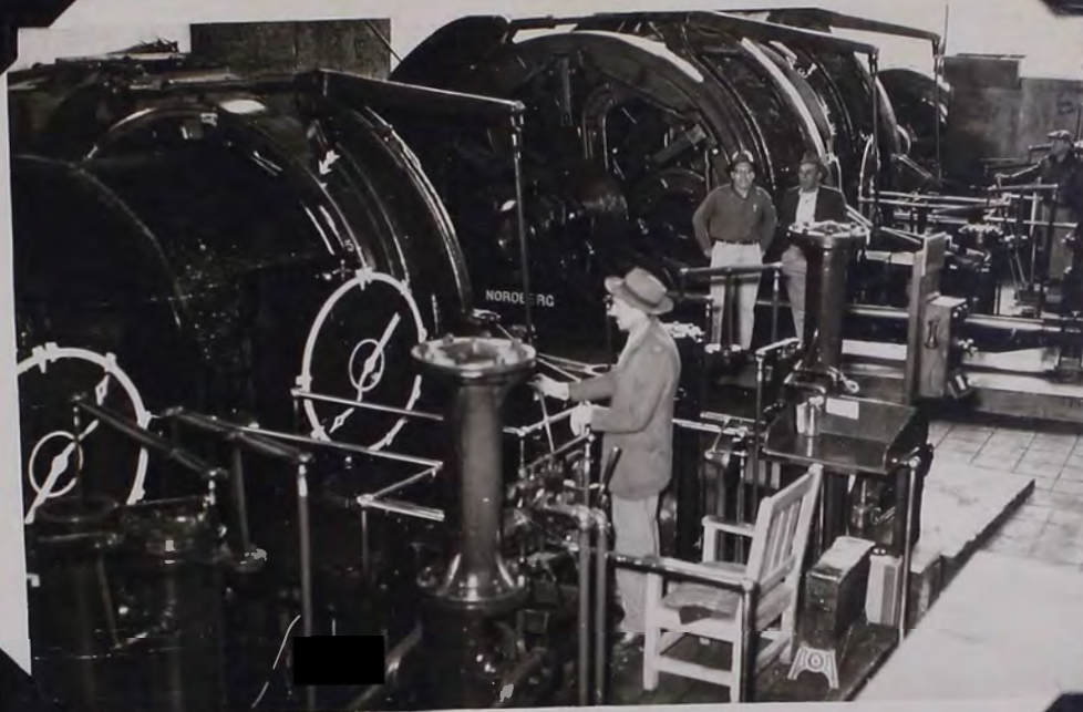
WINCHES DEL PIQUE CENTRAL DE MINA MOROCOCHA
