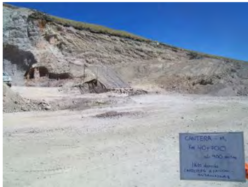
Foto 5: Vista panorámica de la cantera y la zaranda.
