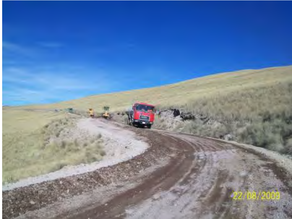
Foto 29: Proceso de mezclado y homogenizado.
