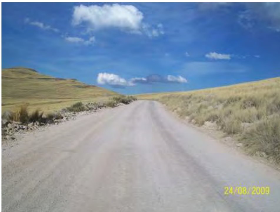
Foto 17: Vista acabado final de la zona de prueba con el aditivo enzimático.
