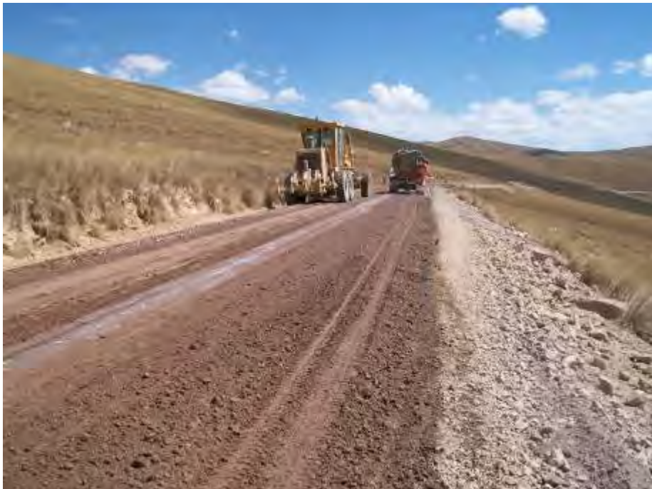
Foto 13: Mezclado y homogenizado del material con el aditivo.
