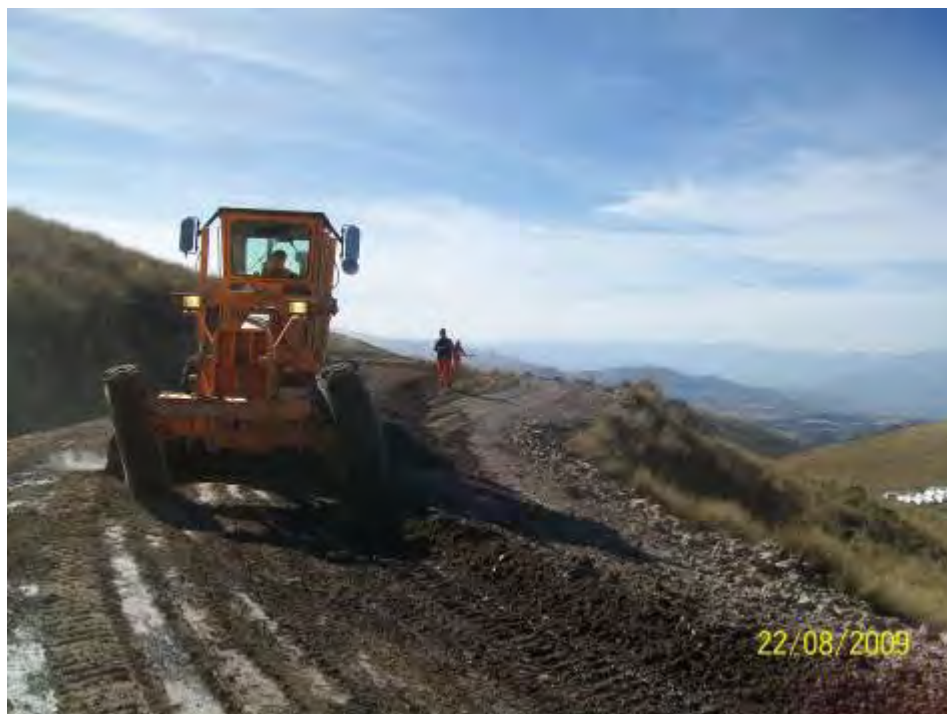
Foto 27: Proceso de mezclado y homogenizado.
