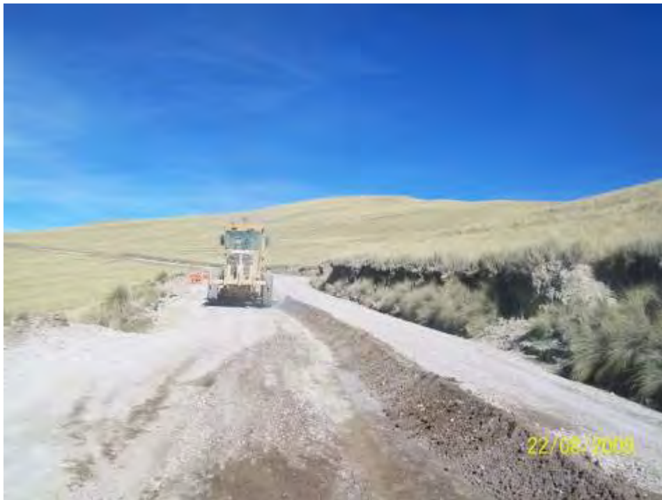
Foto 24: Proceso de tendido del material de préstamo.
