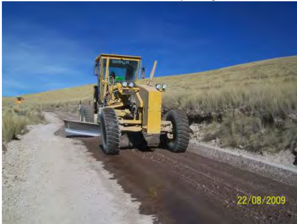
Foto 26: Proceso de mezclado y homogenizado.
