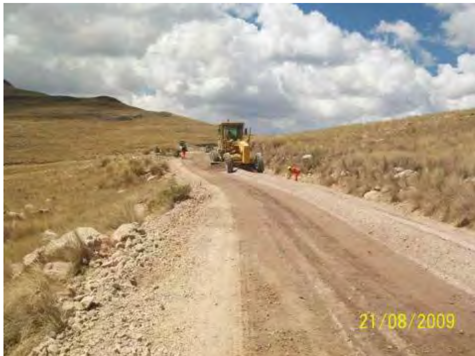
Foto 14: Mezclado y homogenizado del material con el aditivo.
