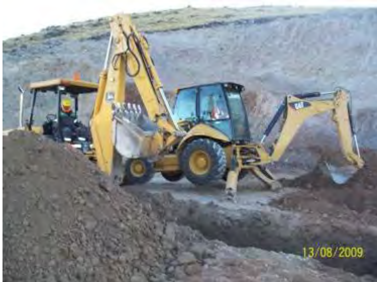
Foto 1: Proceso de conformación de zonas para depósito de material zarandeado y material over.
