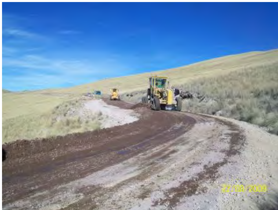
Foto 29: Proceso de mezclado y homogenizado.
