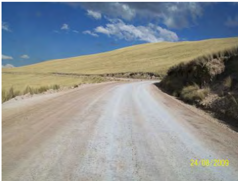
Foto 37: Vista del acabado final después de la aplicación del cloruro de calcio
