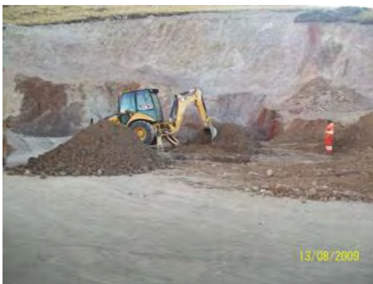
Foto 2: Conformación de zonas de material zarandeado y material over.
