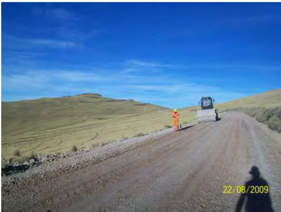
Foto 33: Proceso de compactación
