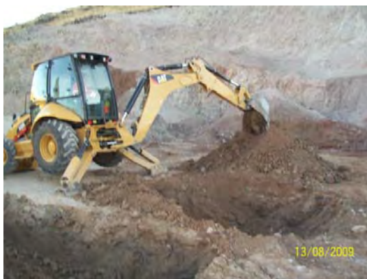
Figura 20: Acondicionamiento de zonas de material para over y material procesado.
