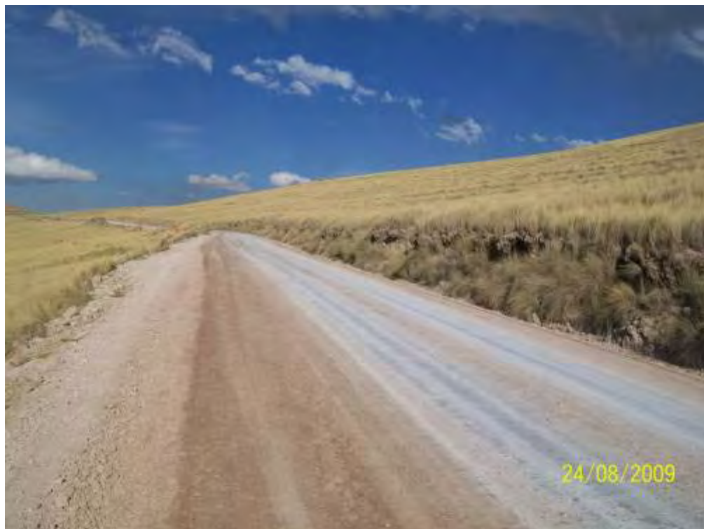
Foto 40: Vista del acabado final después de la aplicación del cloruro de calcio
