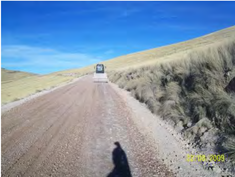
Foto 32: Proceso de compactación
