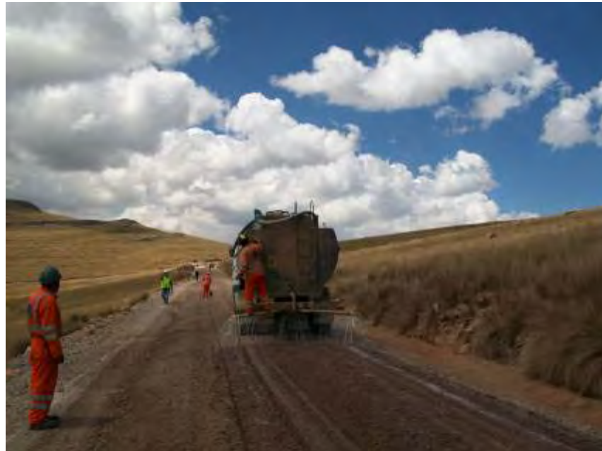
Foto 11: Regado con el aditivo enzimático.
