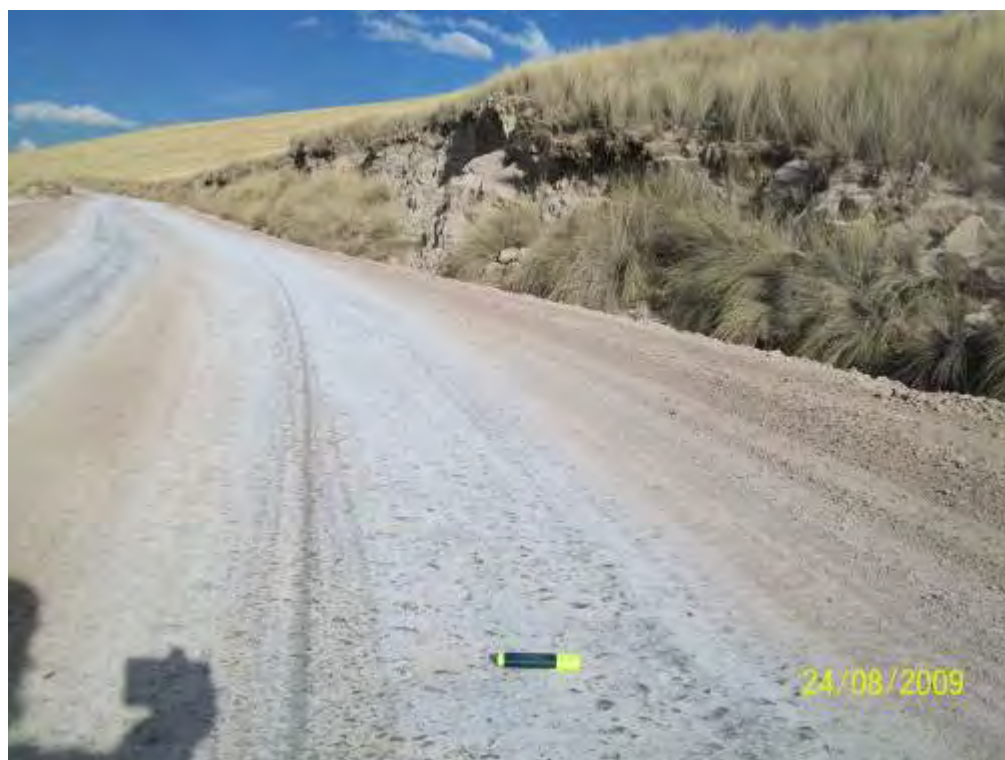
Foto 41: Vista del acabado final después de la aplicación del cloruro de calcio
