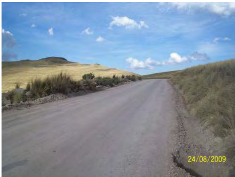
Foto 18: Vista acabado final de la zona de prueba con el aditivo enzimático.
