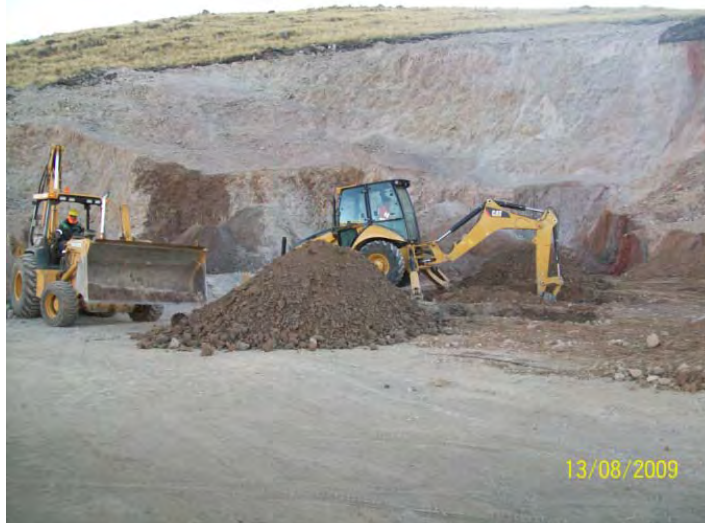
Figura 21: Acondicionamiento de zonas de material para over y material procesado
