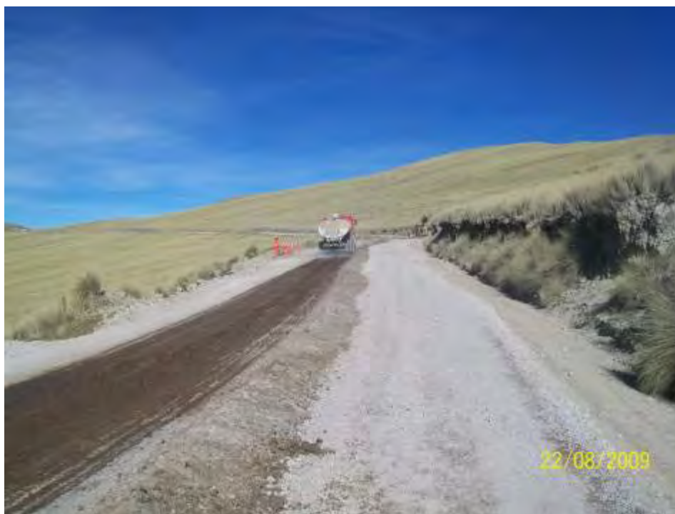
Foto 23: Proceso de humedecimiento y tendido de material acopiado de cantera.
