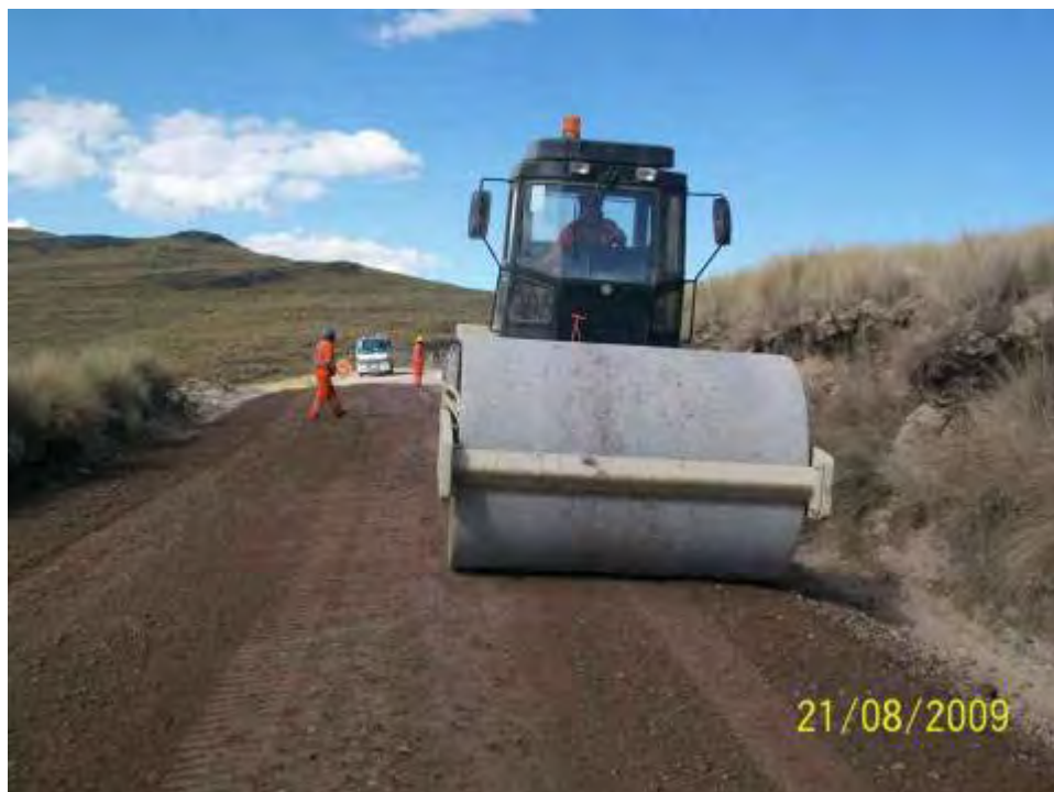
Foto 15: Proceso de compactación
