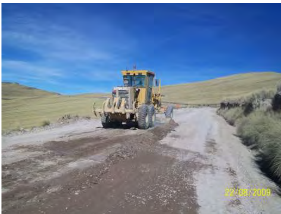
Foto 23: Proceso de humedecimiento y tendido de material acopiado de cantera.
