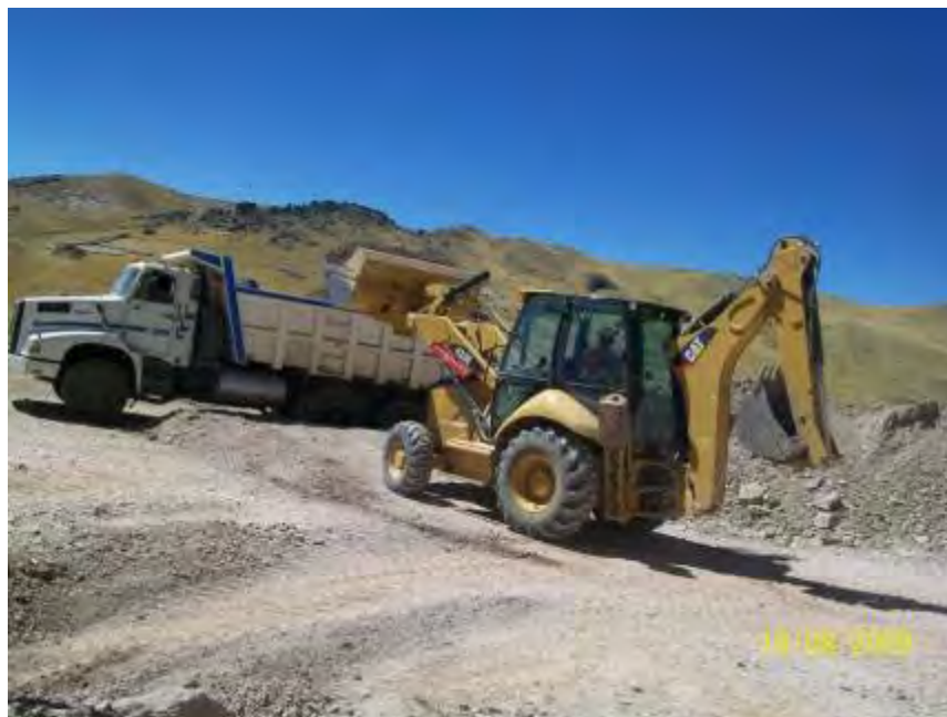
Foto 8: Vista del proceso de carguío a los volquetes.
