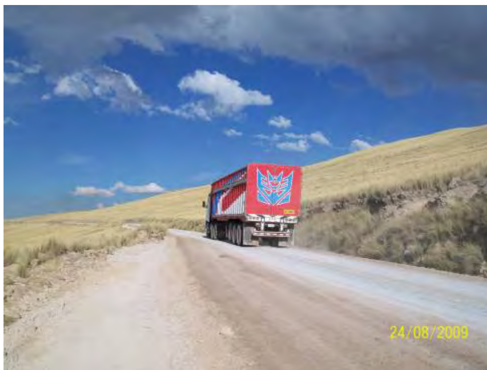
Foto 39: Vista del acabado final después de la aplicación del cloruro de calcio
