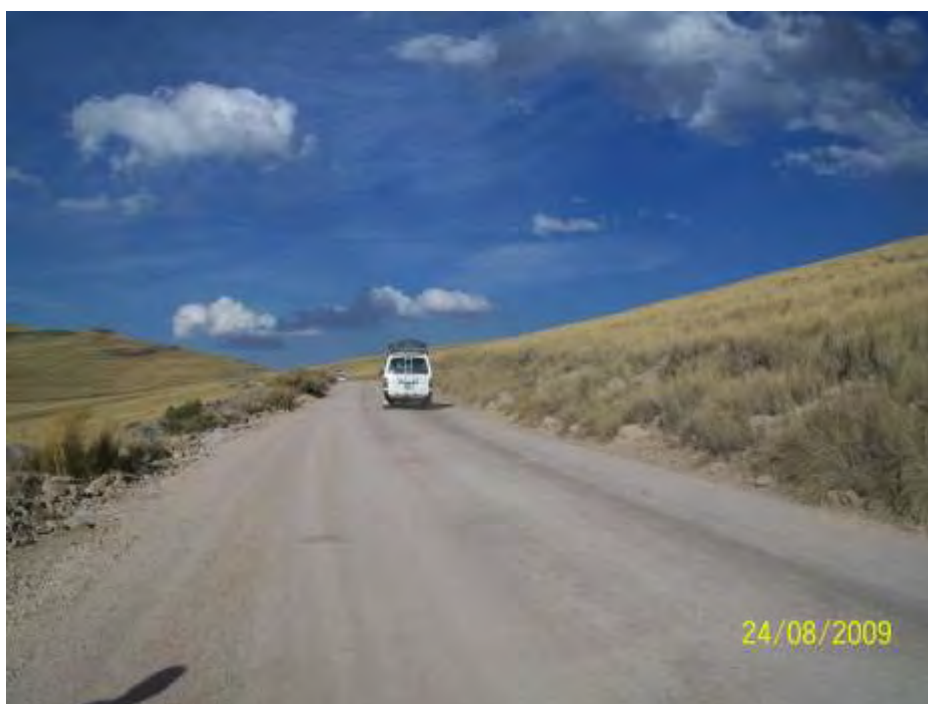
Foto 19: Vista acabado final de la zona de prueba con el aditivo enzimático.
