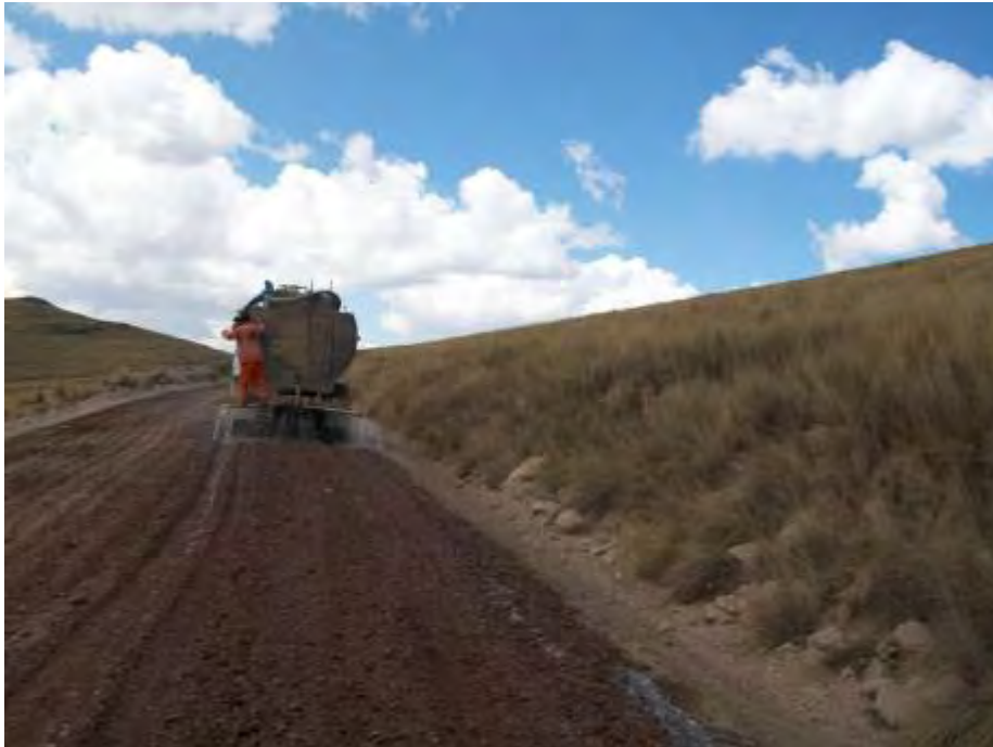
Foto 12: Regado con el aditivo enzimático
