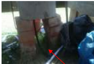
Paso entre el tanque aireado y el sedimentador secundario
