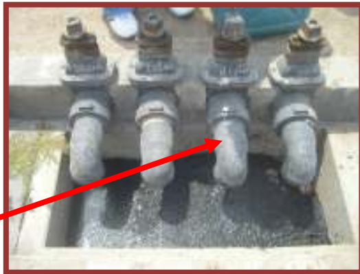
Lodo a una altura de 1.5m del RAFA.
