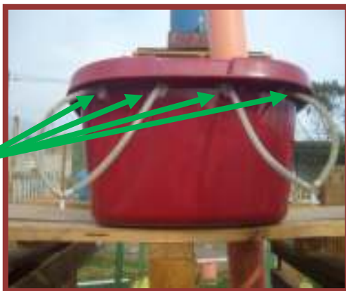
Salidas del sedimentador primario
