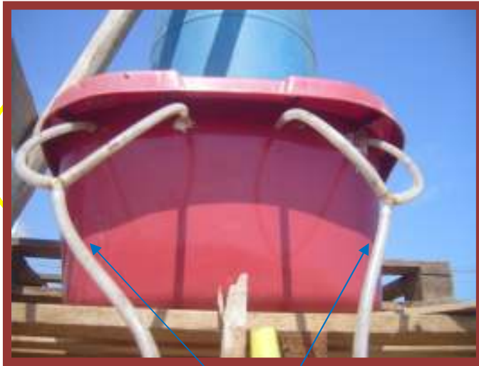
Salida del Tanque de sedimentación y entrada al UASB (entran 02 mangueras al UASB)
