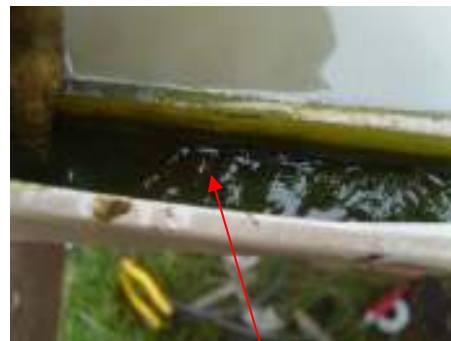
CANAleta DE RECOLECCION DEL SEDIMENTADOR SECUNDARIO
