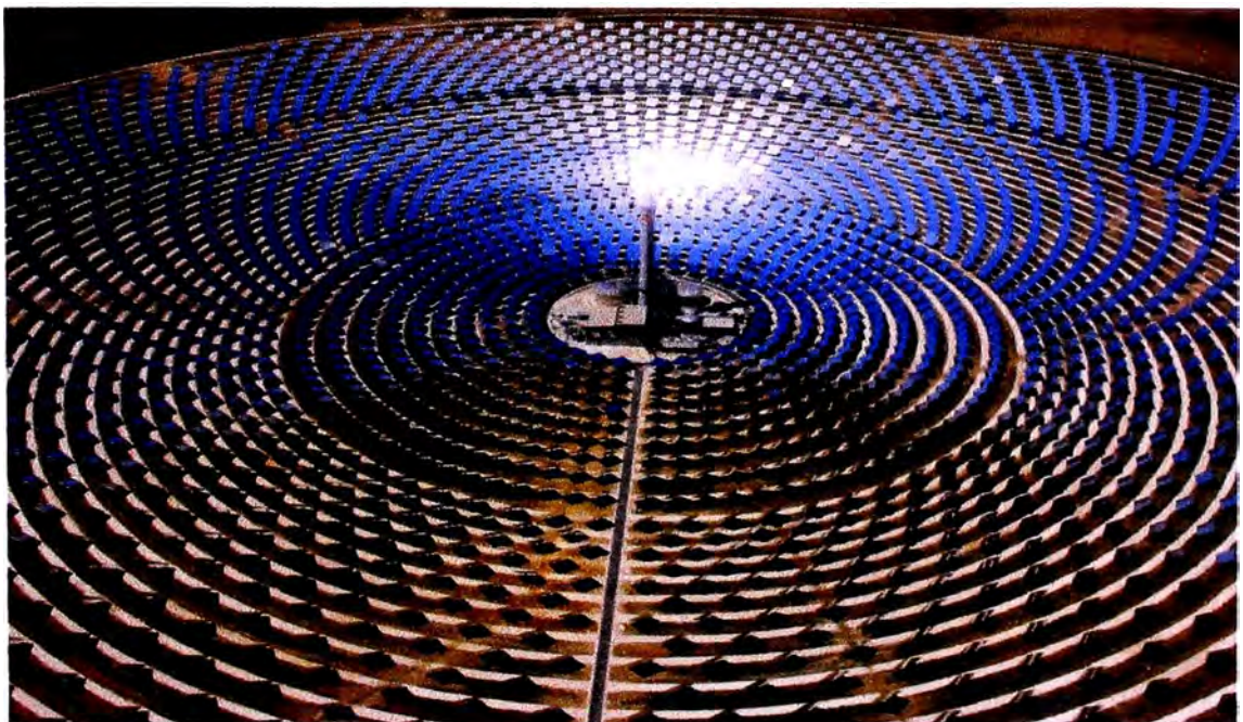
Figura 2.16 Granja solar ubicada en Granada, España, tiene una Potencia eléctrica de 19,9 MW y una producción neta esperada de 110 GWh/año contando con 185 hectáreas de terreno.
