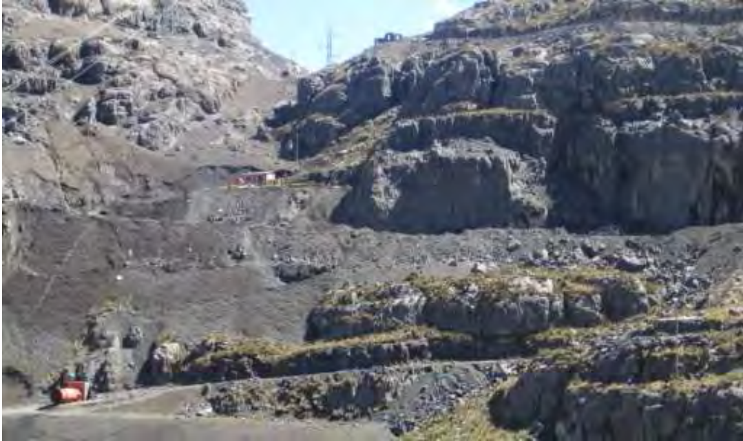
Foto 1: Vista de la carretera a BM 4670 Socorro
