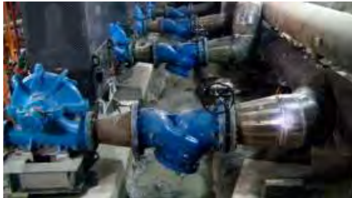
INSTALACION DE TUBERIAS, EN SUB NIVEL RC 736 AL TUNEL PATON NV 4120 y MONTAJE DE SOPORTE PARA TUBERIAS HDPE DE 18" Ø. NV 4120 TUNEL PATON.
