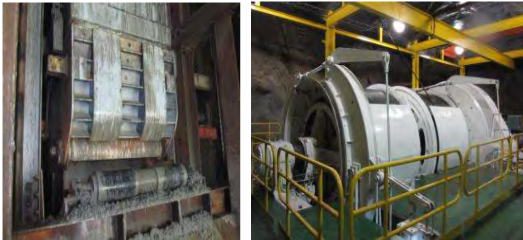
Figura 22: Instalación de Skips tipo rolla shut, nuevo winchw Nordberg
