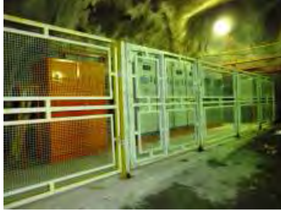
MONTAJE DE 04 BOMBAS GOULDS 3409 DE 900HP
