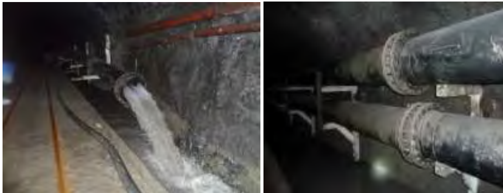
INSTALACION DE TUBERIAS, EN SUB NIVEL RC 736 AL TUNEL PATON NV 4120 y MONTAJE DE SOPORTE PARA TUBERIAS HDPE DE 18" Ø. NV 4120 TUNEL PATON.
