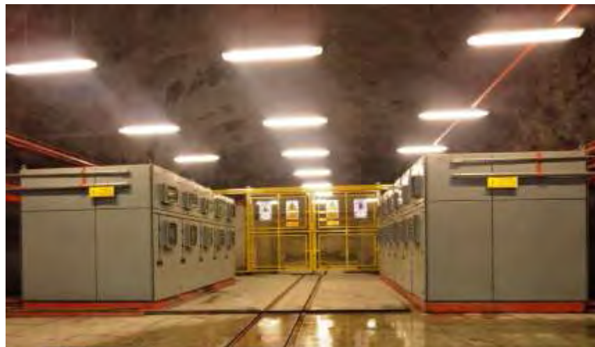
Figura 30: SE Nv 4120 Mina Carmen
