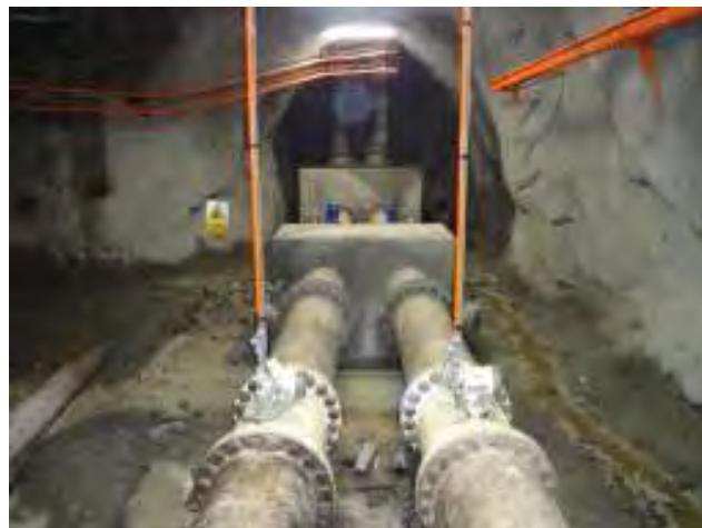
Figura 25: Instalación de Tubería al Rc 736 e instalación de 4 bombas
