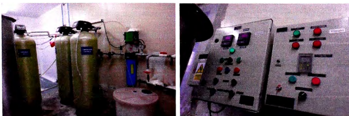
Figura 3.6. Etapa de purificación por método de desionización.
