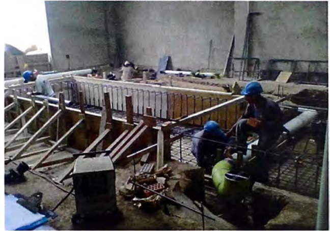
Cimentación de equipos y montaje de tuberías en sala de Pruebas
