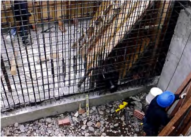
Construcción de cisternas
