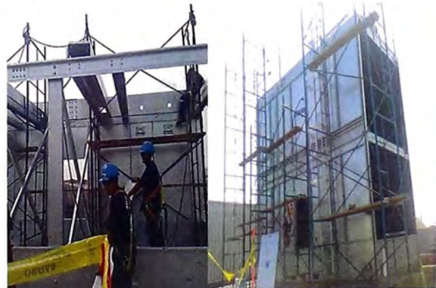
Montaje de Torre de enfriamiento
