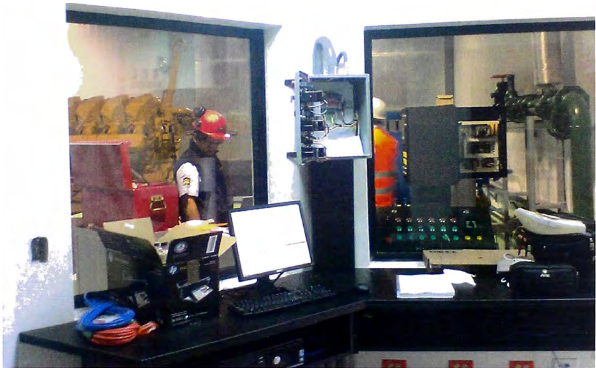
Cuarto de control y monitoreo
