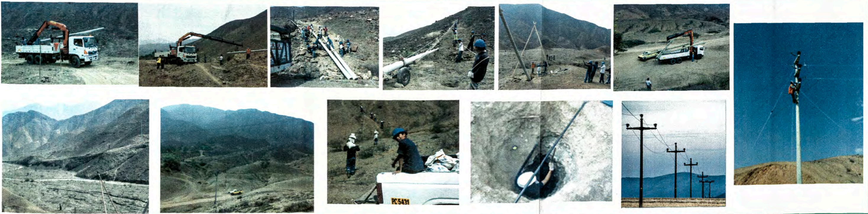
INSTALACION DE LA LINEA 22,9 KV - LONGITUD 4,291 km.
