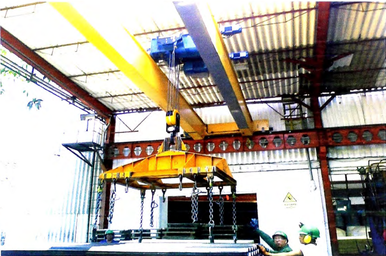
Fig.3.1 Puente grúa en producción de planchas de fibrocemento
