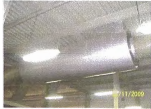
Filtro Humedo y Silenciador de Aire de Admisión
