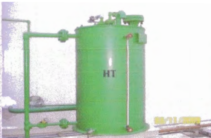
Tanques de Expansión
