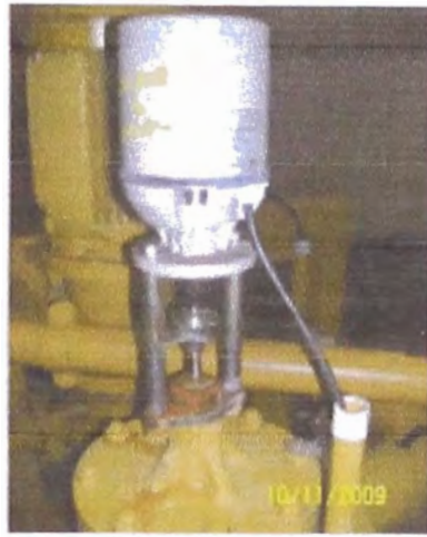
Valvulas de 3 vias – Termostaticas HT y LT
