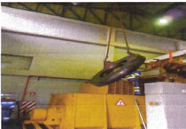
Desmontaje de volante
