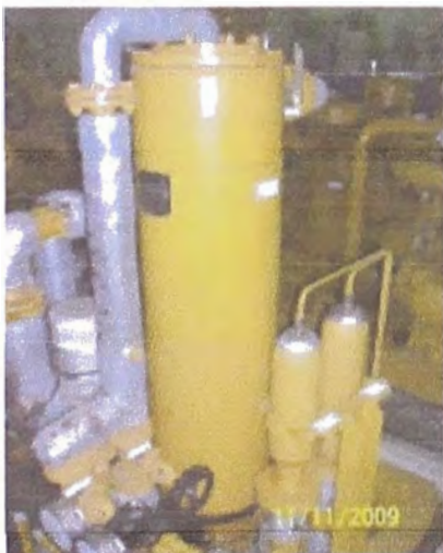
Calentador de HFO y bombas de circulación HFO
