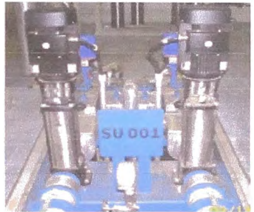
Tanque y electrobombas para agua de caldera.
