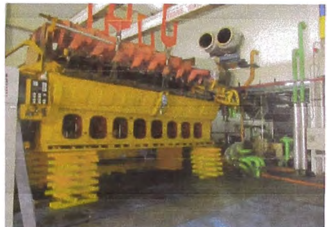
Motor izado y embancado
