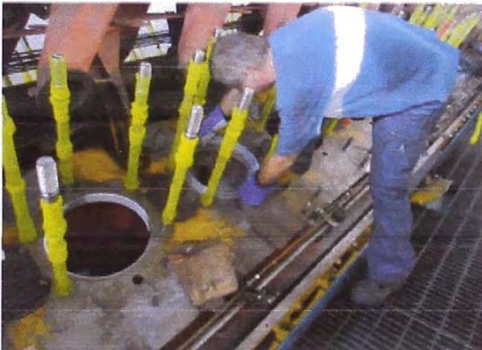
Instalación de insert rings
