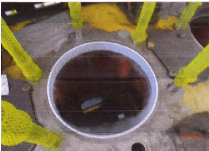
Insert rings instalados
