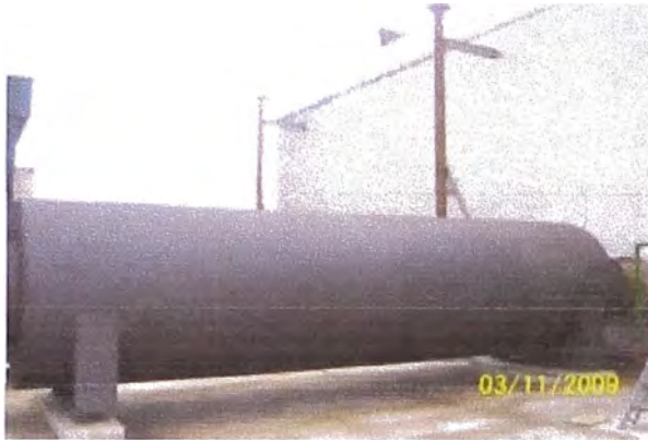
Silenciador y Caldera de gases de escape
