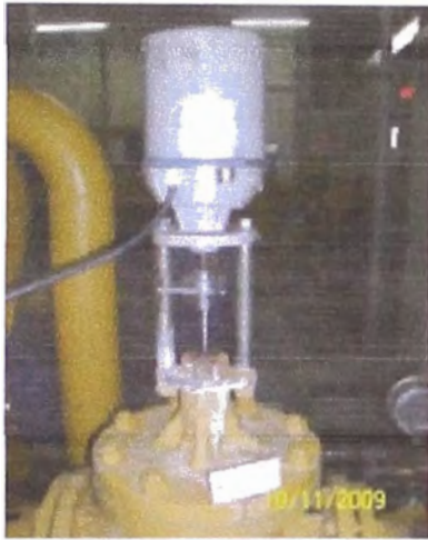
Valvulas de 3 vias – Termostaticas HT y LT
