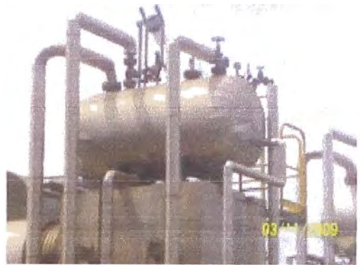
Silenciador y Caldera de gases de escape
