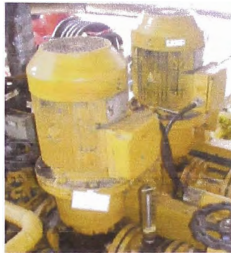
Filtro Automático HFO y bombas de pre-presión HFO
