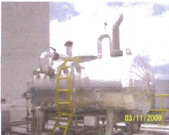
Tanque y electrobombas para agua de caldera.
