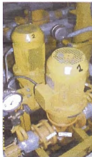
Calentador de HFO y bombas de circulación HFO
