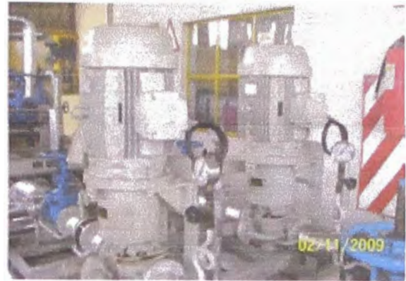
Tanque y bombas de transferencia HFO
