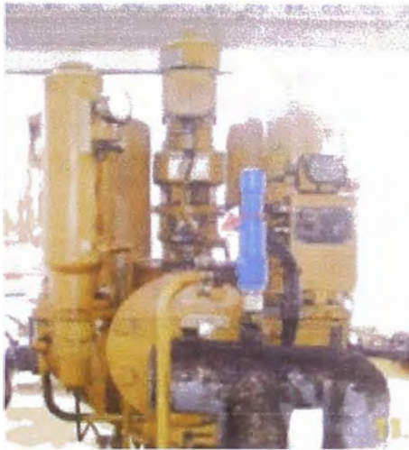
Filtro Automático HFO y bombas de pre-presión HFO
