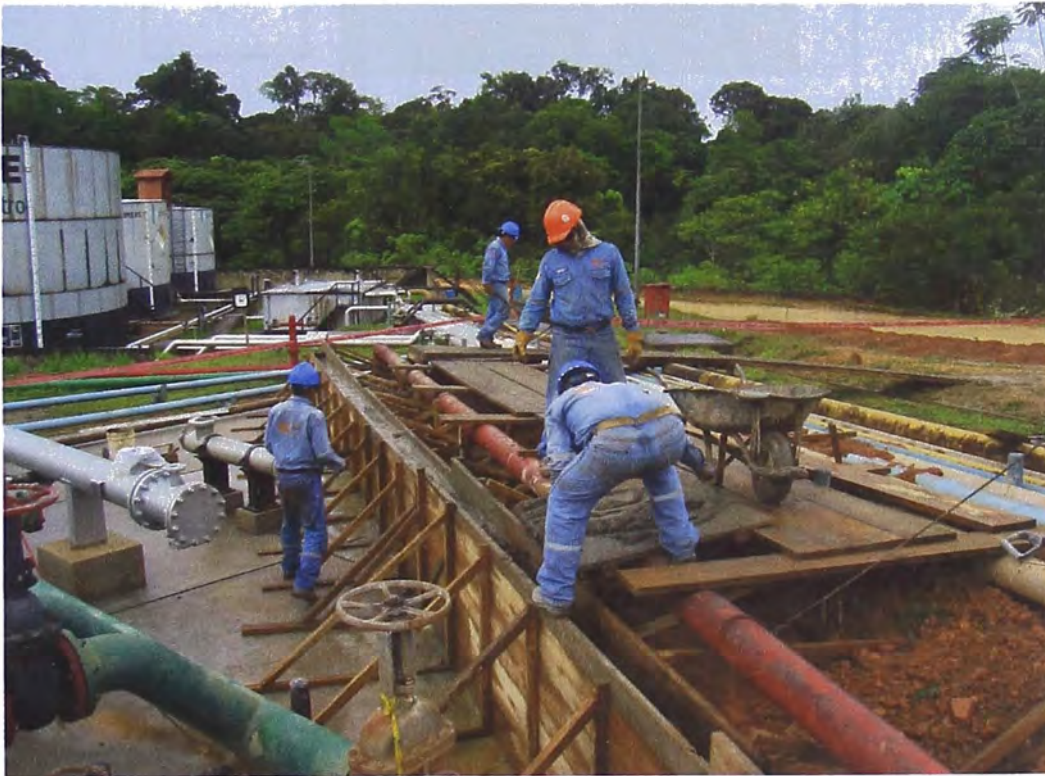
Figura 5.8: Construcción de losa y muro para intercambiador
