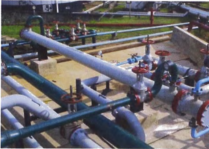
Figura 5.15: Intercambiador de calor instalado
