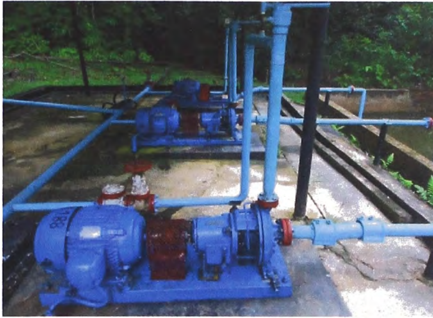
Fig 2.20: Captación de Agua PA 149 para Batería 9
