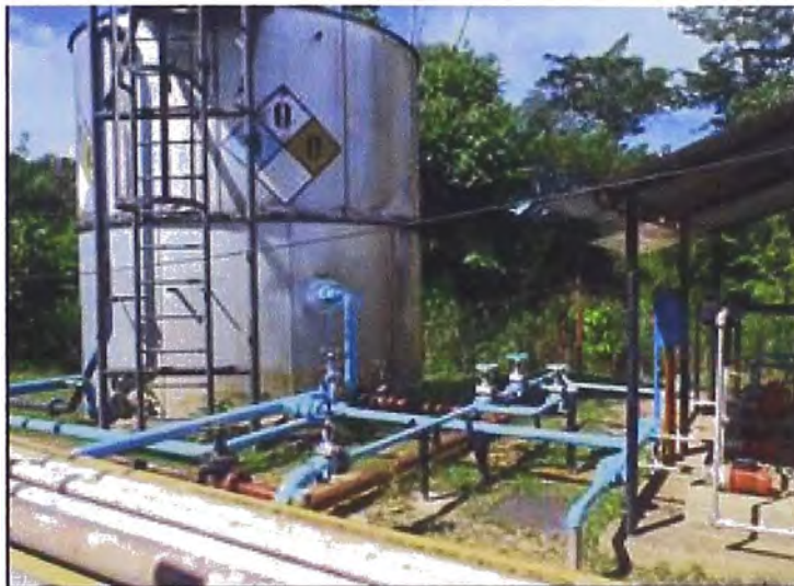
Figura 5.13: Interconexión de líneas para electrobomba
