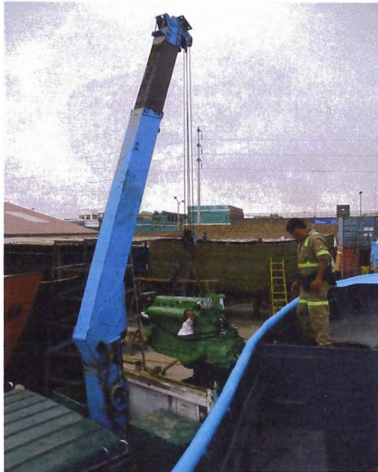
Figura 4. 17 Montaje de Motor con grúa, Fuente: Elaboración propia
