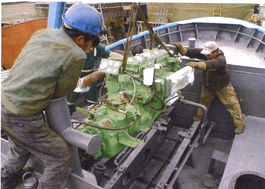
Figura 4. 18 Colocación de Motor, Fuente: Elaboración propia
