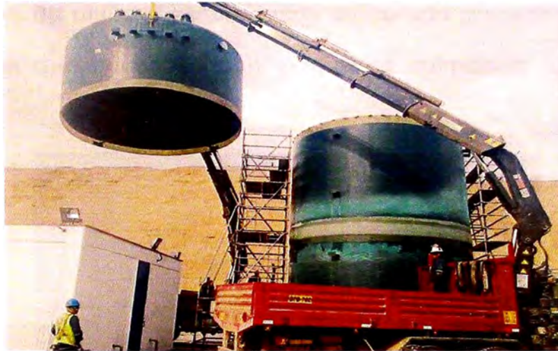
Figura 6.22 MONTAJE DEL CILINDRO SUPERIOR.
