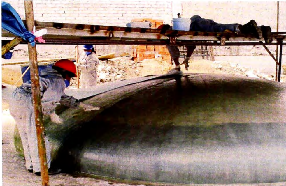
Figura 6.3 APLICACIÓN DE LA RESINA Y LAMINADO CON EL RODILLO METÁLICO PARA CONSEGUIR UN LAMINADO HOMOGÉNEO Y ELIMINAR BURBUJAS DE AIRE.
