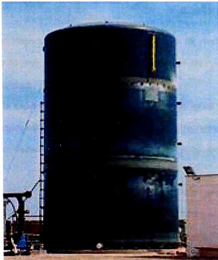
Figura 6.23 CILINDRO DE 300M3 DE FRP INSTALADO.
