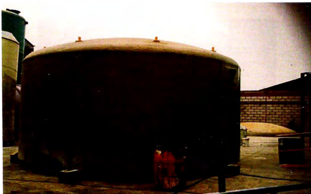
Figura 6.15 CILINDRO 3 CON TAPA TORIESFÉRICA.
