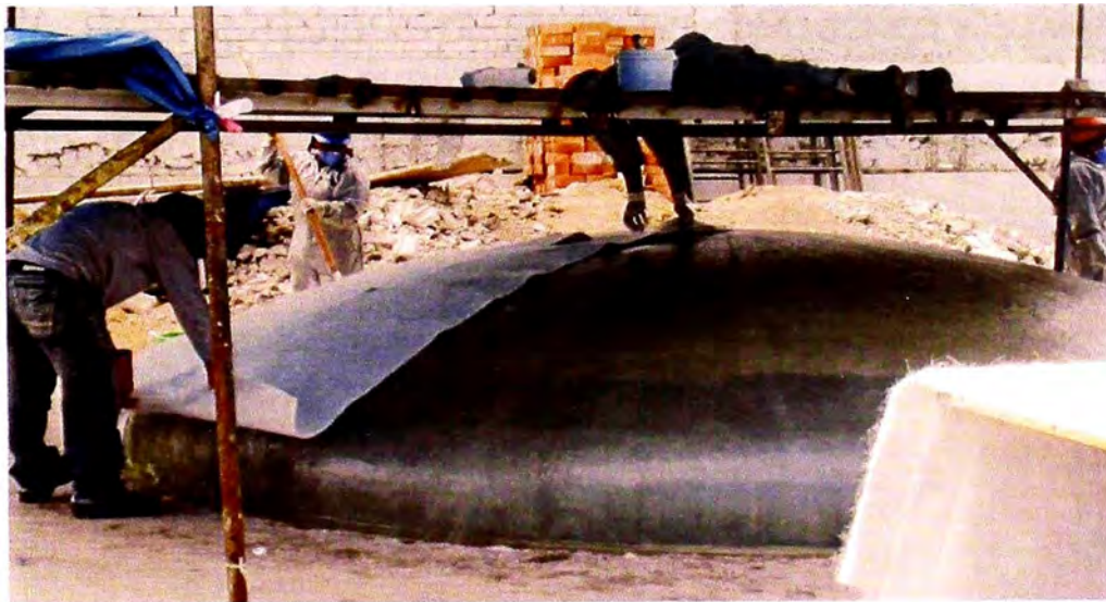
Figura 6.2 APLICACIÓN DE LAS CAPAS DE MANTA DE FIBRA PICADA (MAT 450).
