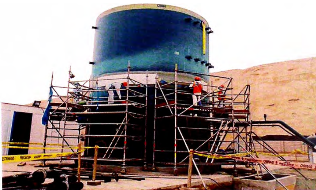
Figura 6.21 VENDAJE DE LOS CILINDRO 1 Y 2, LAMINADO MANUAL.
