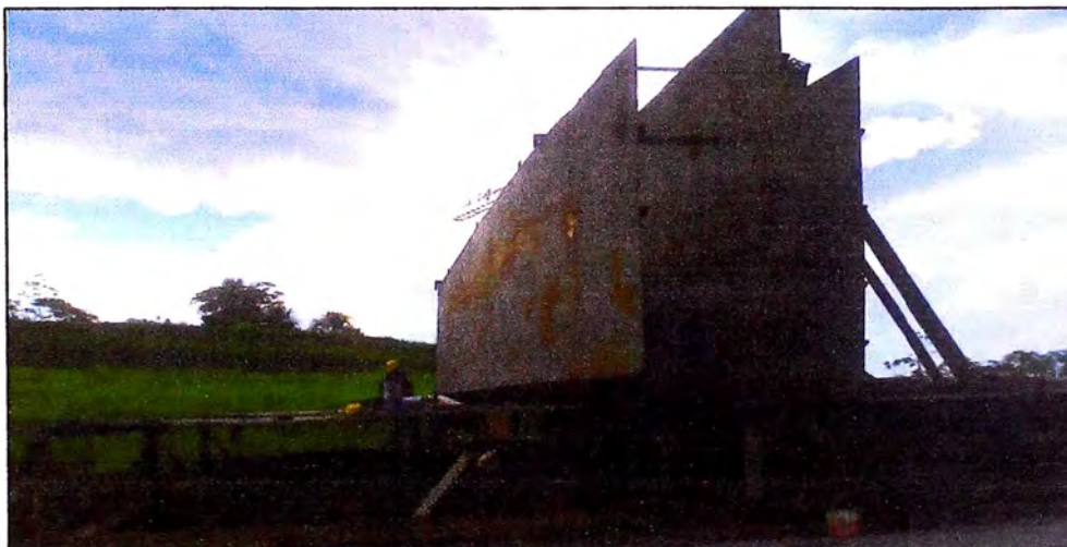
Figura 2.41 Mamparo Transversal Montado con puntales de apoyo hasta completar la soldadura y sus refuerzos.
