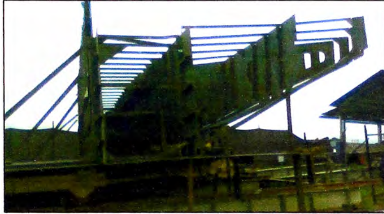
Figura 2.50 Modulo de Proa, Instalación de Mamparos y longitudinales de fondo y cubierta
