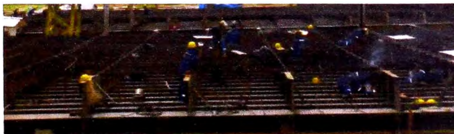
Figura 2.47 Longitudinales de Cubierta de Doble Fondo
