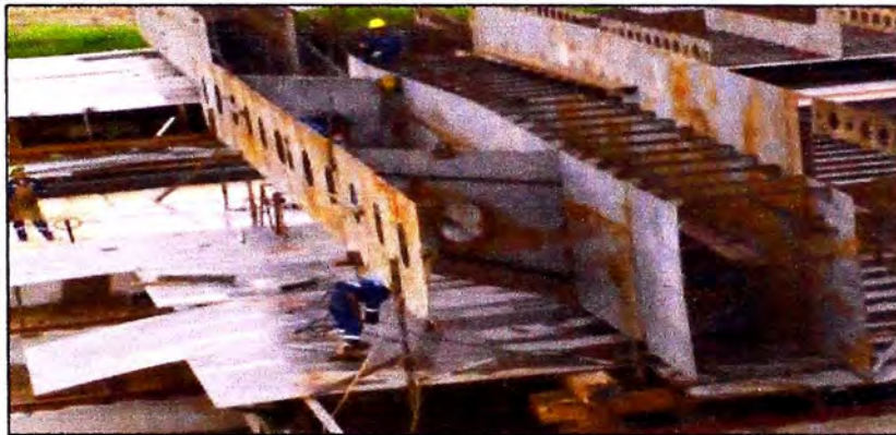
Figura 2.51 Modulo de Popa, Instalación de Mamparos y longitudinales de fondo y cubierta
