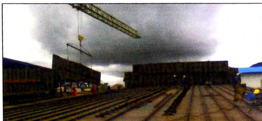
Figura 2.37 Maniobra Erección Mamparo Longitudinal
