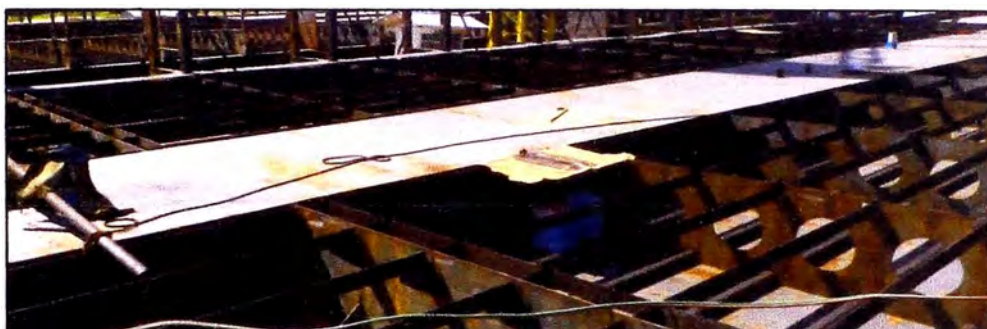
Figura 2.48 Instalación de Plancha de doble Banda BR
