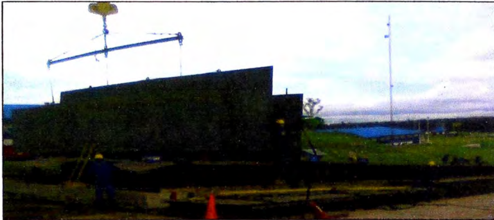
Figura 2.39 Izaje del Mamparo Transversal
