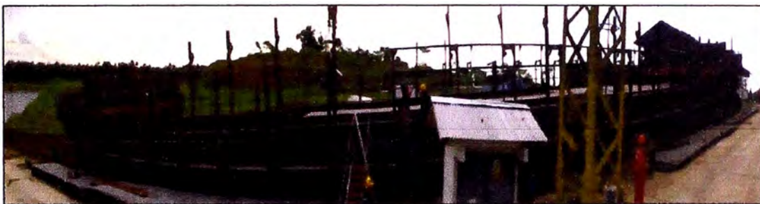
Figura 2.46 Cuadernas y Bulárcamas Montadas
