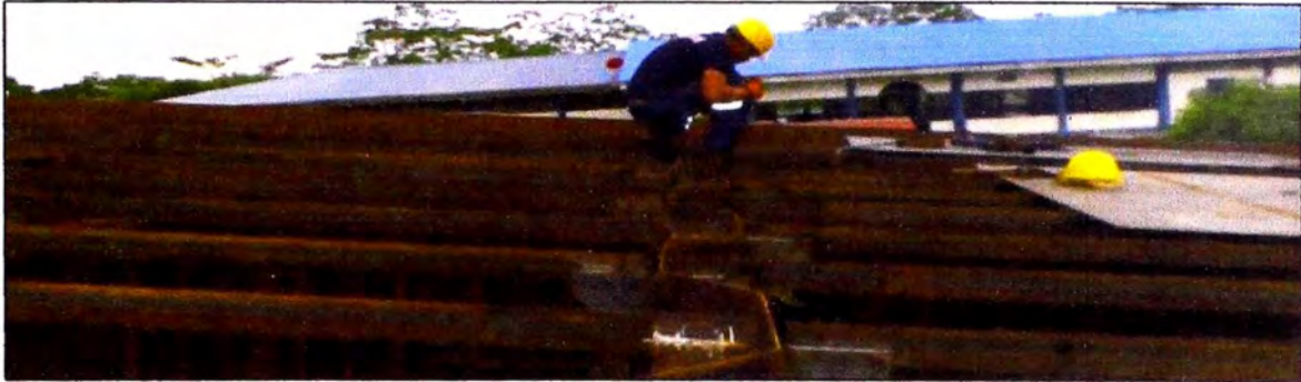
Figura 2.57 Instalación de Longitudinales de Cubierta y Forro de Cubierta
