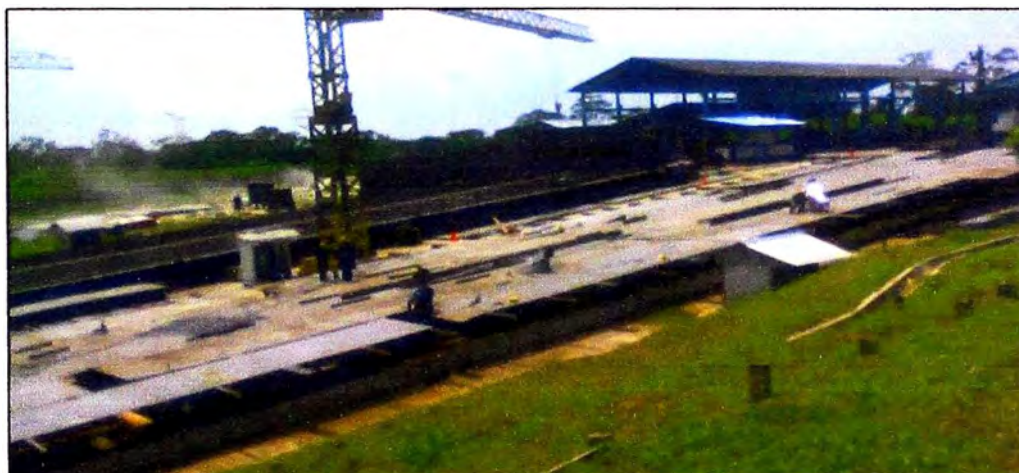
Figura 2.23 Colocación de Plancha de Fondo de la Motochata
