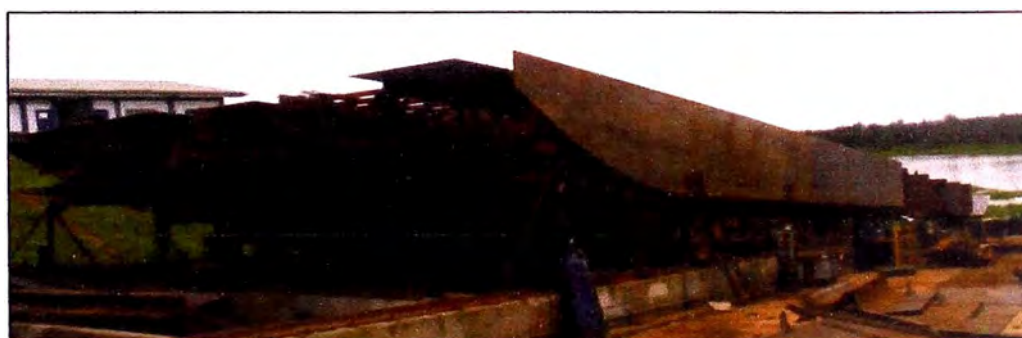
Figura 2.49 Instalación de Plancha de Banda Br-Proa
