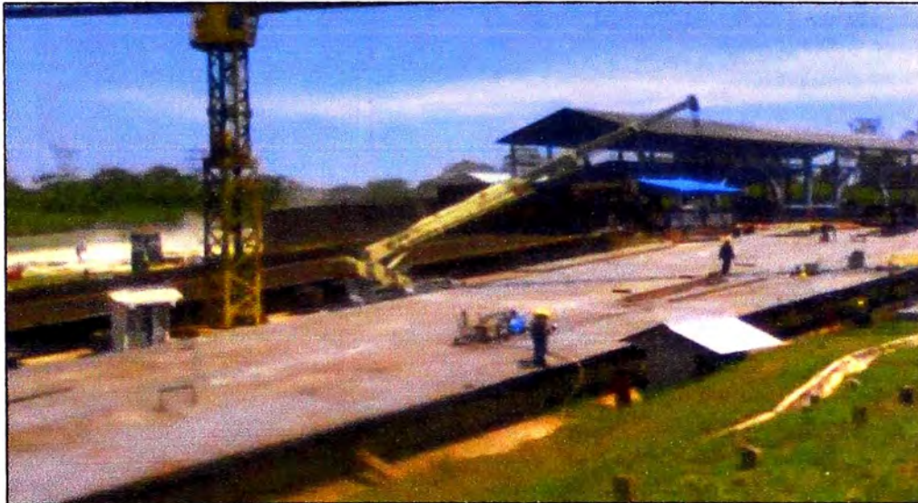
Figura 2.25 Alineamiento y Soldadura de Planchas de Fondo
