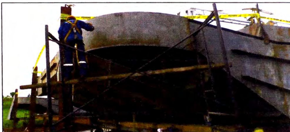
Figura 2.55 Proceso de Instalación de Forro de Costado de Proa-Babor
