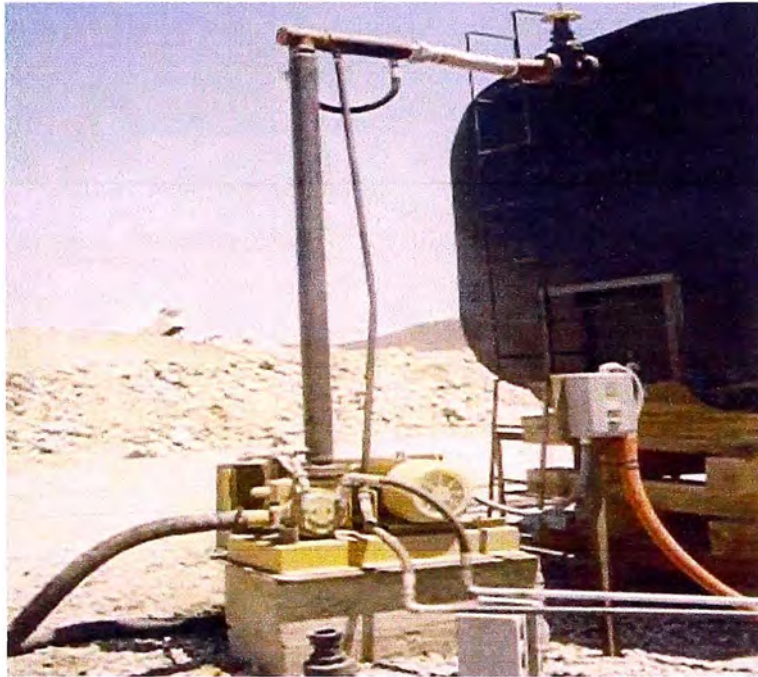
Fig. 3.12 Carga y descarga de cemento asfáltico
