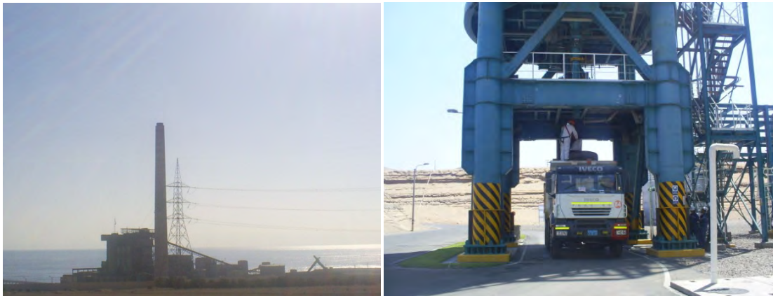
Figura 4.03: Vista de la Planta y Zona de Obtención de Ceniza Volante
