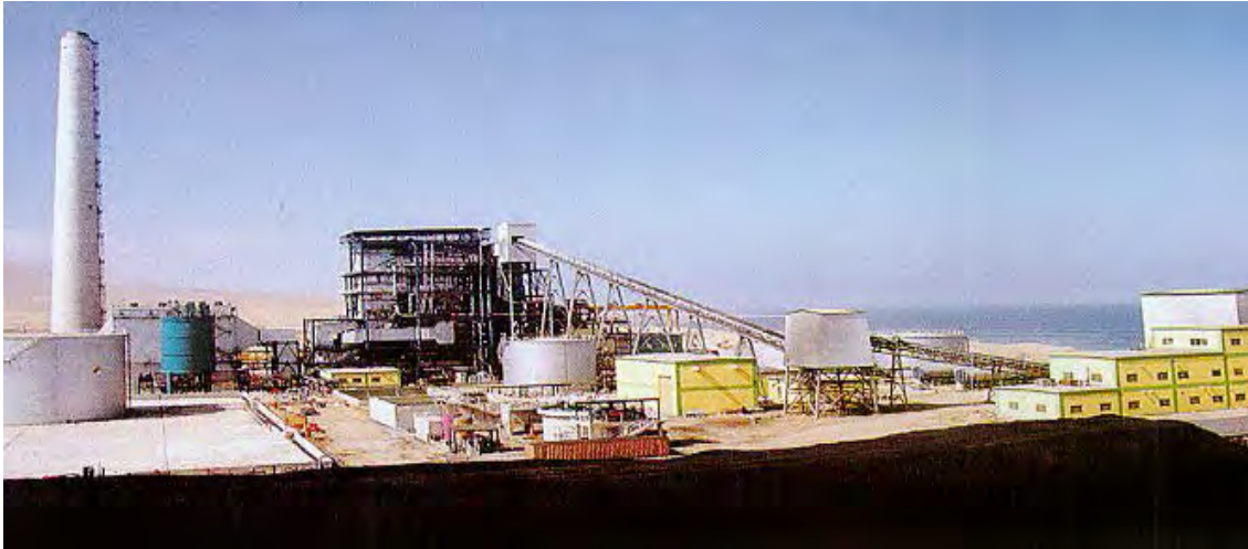
Figura 3.02. Vista General de la Central Termoeléctrica ILO21
