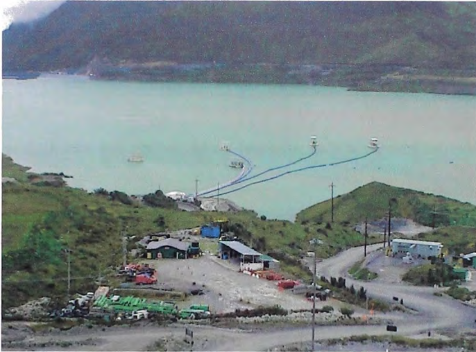
Figura 2.5 Zona profunda de agua formada al centro de la poza de relaves donde se instalan las barcazas
