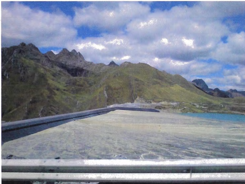
Figura 2.4 Arenado producido por las partículas solidas en uno de los extremos de la poza de relaves, lado Norte.
